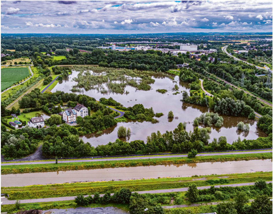
Abbildung 2: Das Hochwasserrückhaltebecken Emscher-Auen.
