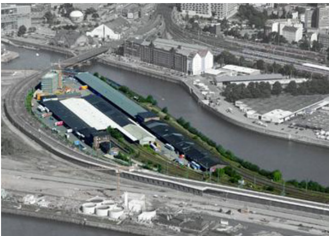
Abb.10: Oberhafen aus der Vogelperspektive, Blick Richtung Norden
