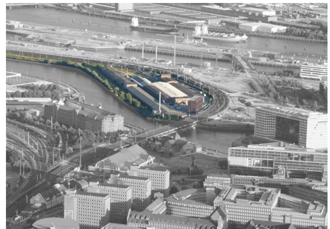
Abb. 11: Oberhafen aus der Vogelperspektive, Blick Richtung Süden
