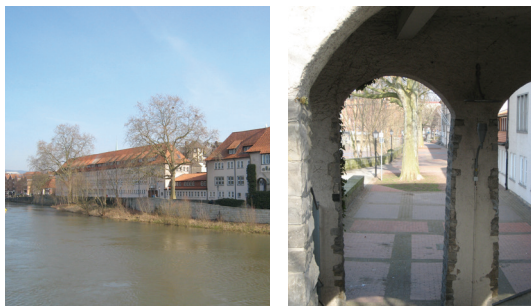
Abb. 67: Wenig einladende Uferpromenade im Bestand
