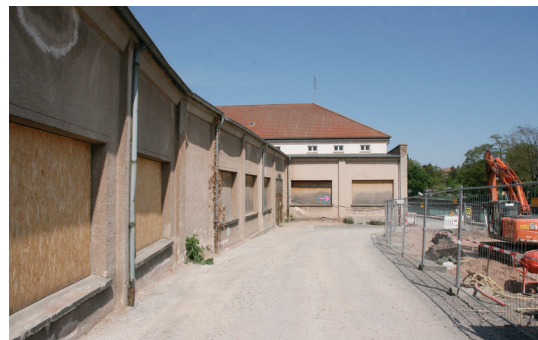
Abb. 72: Aktuelle Eingangssituation Südspitze
