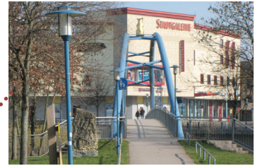
Abb. 46: Fußgängerbrücke mit ECE
