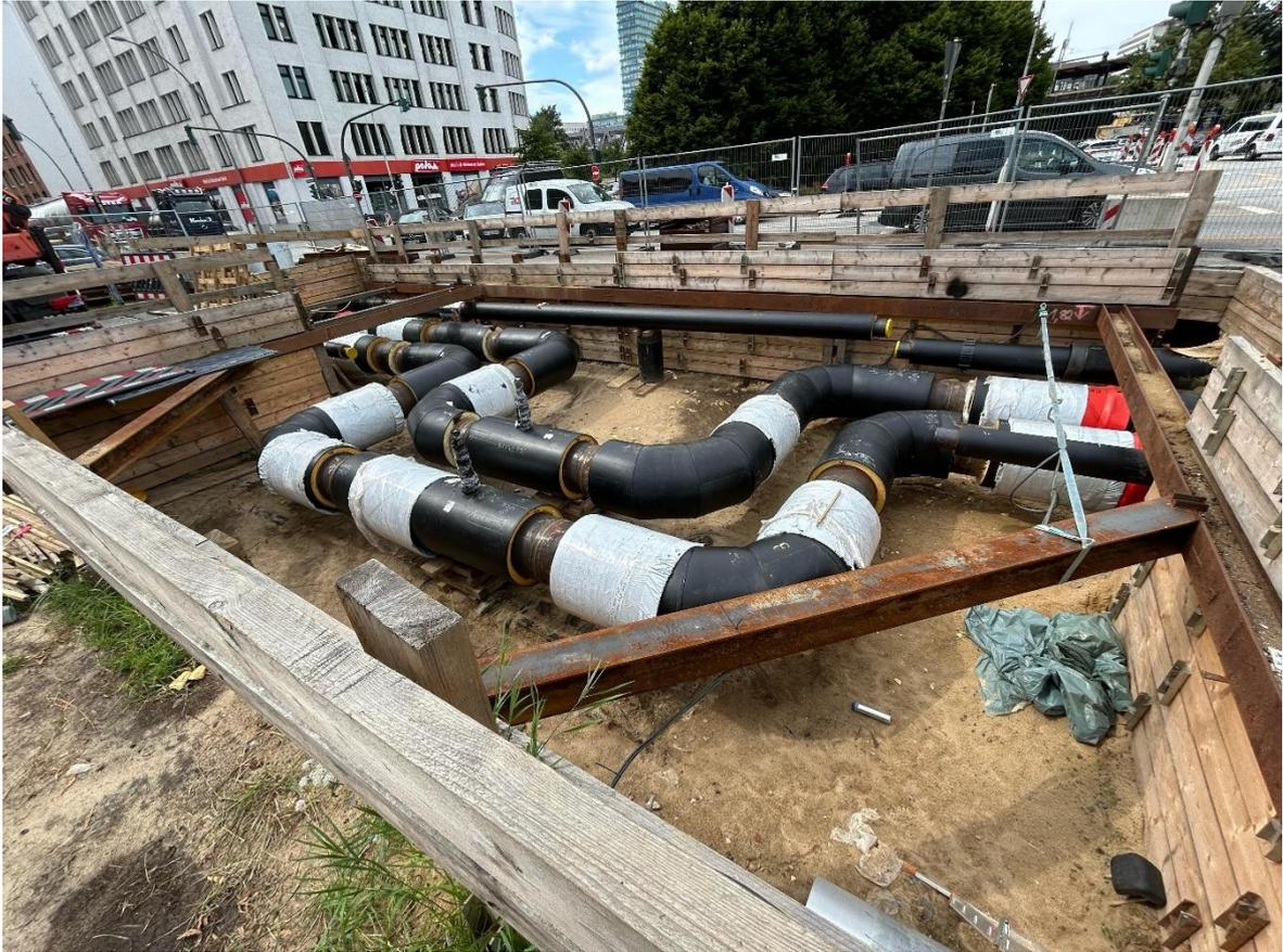
Abb. 4: U-Bogen im Fernwärmesystem: Bauvorhaben HH, Anckelmannsplatz [Eigene Darstellung]
