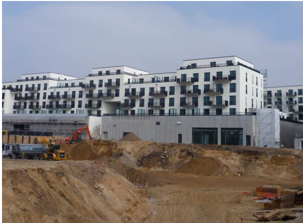
Abbildung 13: Realisierte Bebauung aus Richtung Geibelstraße (Quelle: eigene Darstellung)
