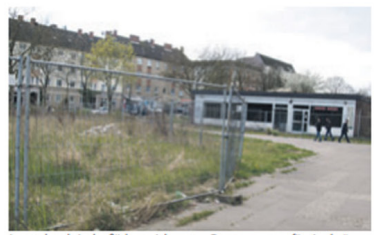
Leerstehende Ladenflächen mit kaputten Fensterscheiben sorgen für eine beängstigende Atmosphäre im Korallusviertel. Foto: au
