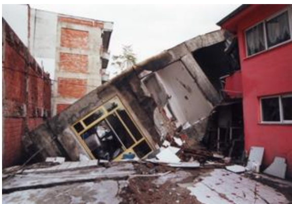
e) Verlust der Tragfähigkeit des Bodens in der Innenstadt von Adapazeri/Sakaya
