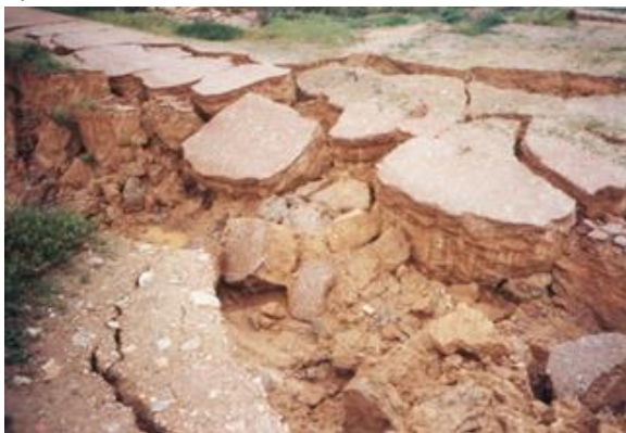
c) Lateral spreading in der Nähe von Chiguana
