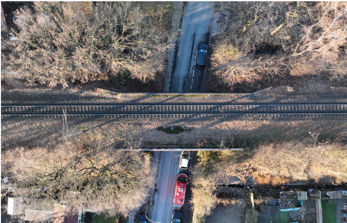
Abb. 27: Exemplarische Bauvorleistung einer Eisenbahnüberführung am Bollweg
