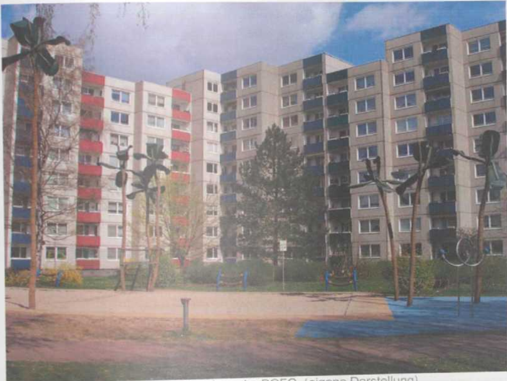
Abbildung 21: Innenhof der Wohnanlage der BGFG. (eigene Darstellung)
