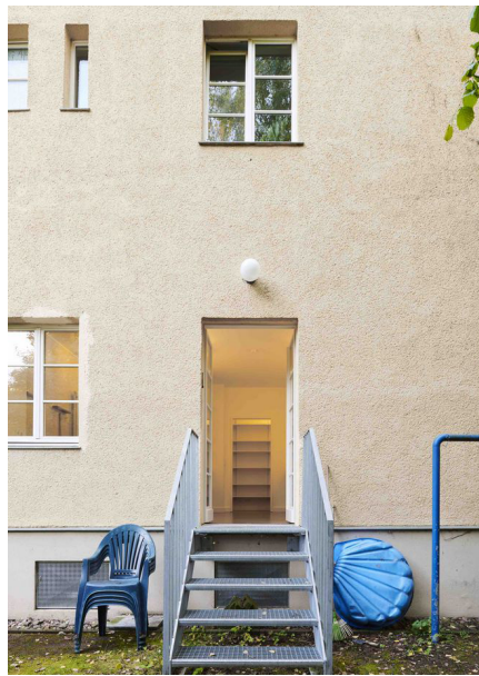
Abb. 46: Neuer Wohnungszugang zum Innenhof (2021) Foto/Quelle: Andrew Alberts / Von Beckerath/Schönig 2022: 187
