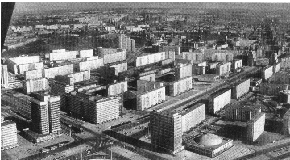
Abb. 6: Der zweite Bauabschnitt der Karl-Marx-Allee, um 1970
