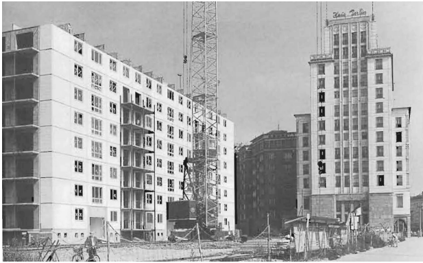
Abb. 24: Bau eines achtgeschossigen Scheibenhochhaus
