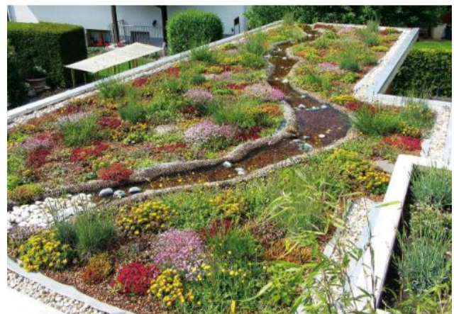
Abb. 11: Wasserfläche auf dem Dach (Firma Zinco)
