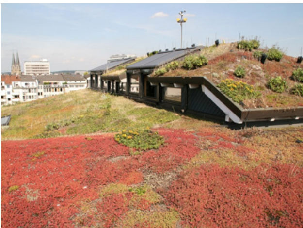
Abb. 6 und 7: Blick auf eine extensive Dachbegrünung oberhalb eines Parkhauses in der Düsseldorfer Innenstadt
