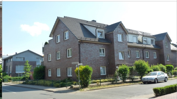
Beispiel eines MFH Neubaus, von denen einige im Teilgebiet zu finden sind.
