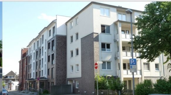
MFH Neubau mit fünf Vollgeschossen.
