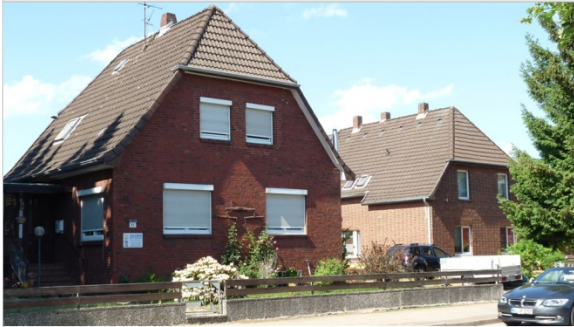
Alte EFH aus den 50er und 60er Jahren prägen zum Teil das Gebiet.
