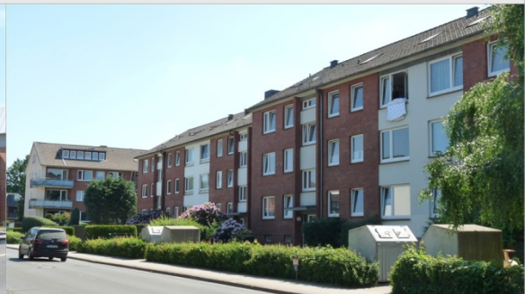
Weitere MFH entlang der Hauptstraße in einem von Wohnungsbau geprägten Gebiet.
