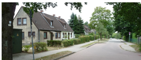
Abbildung 61: Typische, vorwiegend allerdings sehr sanierungsbedürftige Zweifamilienhäuser Quelle: Eigenes Foto
