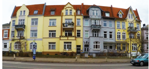
Abb. 2.2.2.3: Guter Zustand der Gestalt der Gebäude
