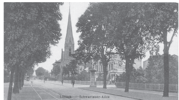
Abb. 2.3.1.1: Straßenbahnschienen führten durch die Schwartauer Allee
