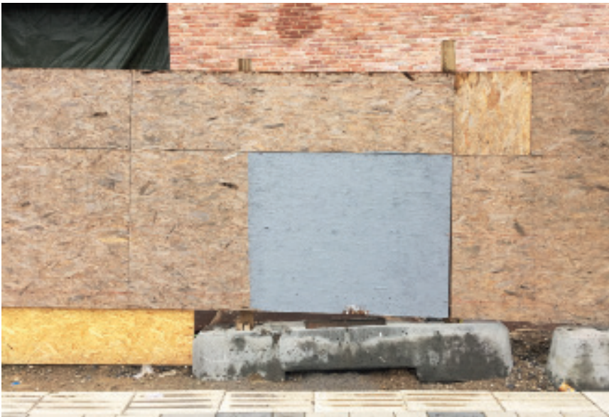
Abb. 19 Sichtbarkeit vs. Unsichtbarkeit, Bauzaun mit übermahltem Graffiti
