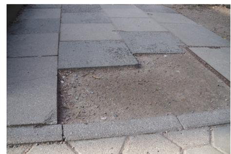
Abb. 18: Fehlerhafte Pflasterung
