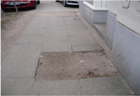
Abb. 40: Fehlerhafte Pflasterung 2
