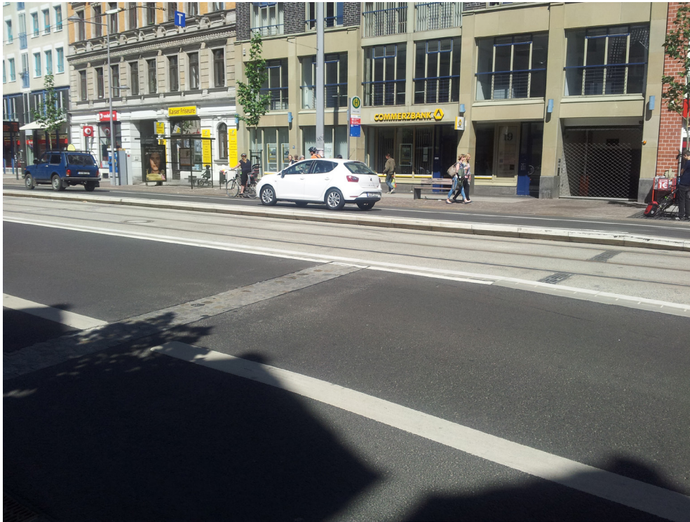
Abb. 65: Kaphaltestelle mit angehobener Fahrbahn und besonderen Bahnkörper für die Straßenbahn in Leipzig, Quelle: Eigene Abbildung.
