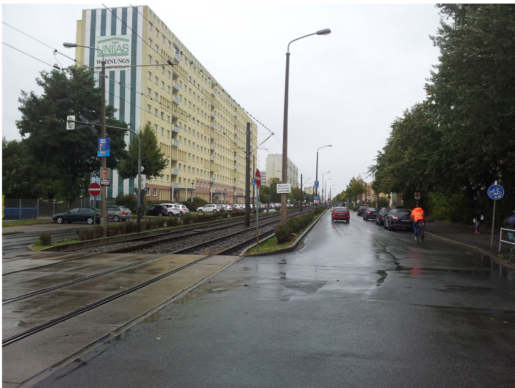
Abb. 57: Führung der Straßenbahn auf besonderen Bahnkörper mit offenem Schotteroberbau, trennender Vegetation und Kettenfahrleitung in Leipzig, Quelle: Eigene Abbildung.
