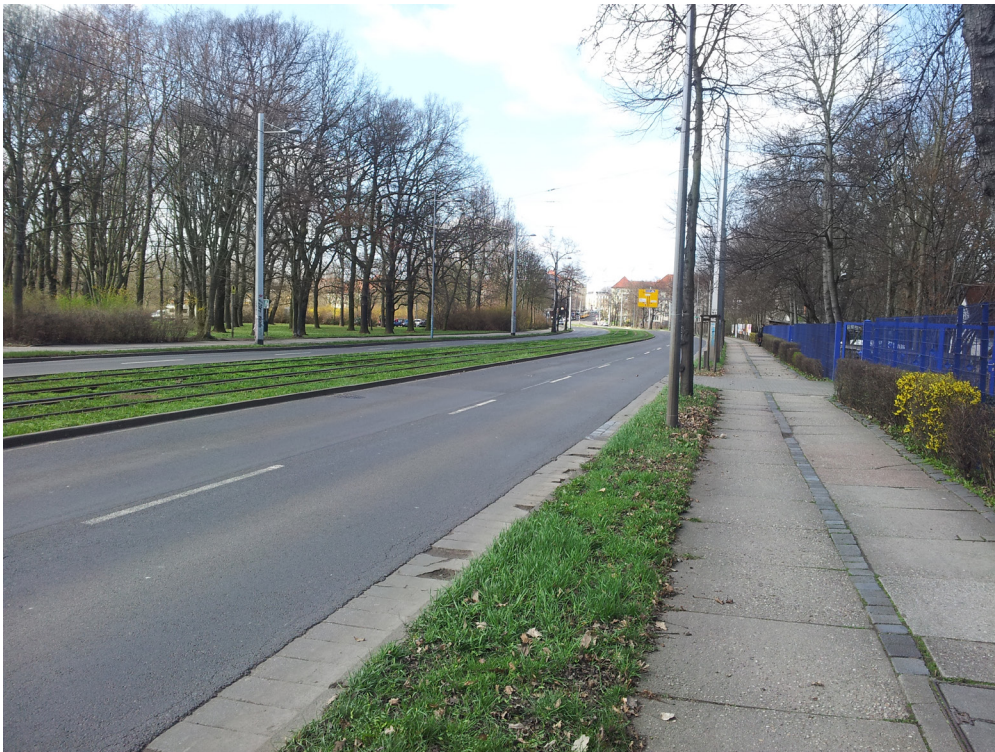
Abb. 55: Führung der Straßenbahn auf besonderen Bahnkörper mit Rasengleis und Kettenfahrleitung in Leipzig, Quelle: Eigene Abbildung.
