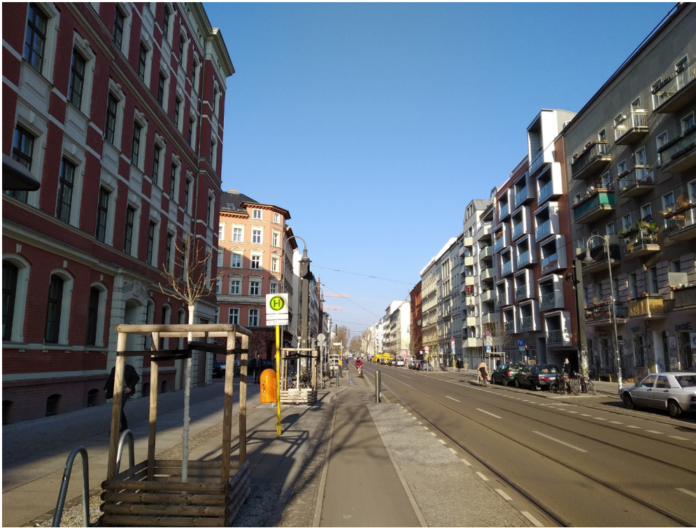
Abb. 54: Führung der Straßenbahn im Mischverkehr und Einfachfahrleitung in Berlin, Quelle: Eigene Abbildung.
