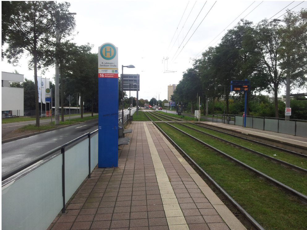
Abb. 64: Haltestelleinsel der Straßenbahn in Leipzig in Form von Seitenbahnsteigen zwischen Bahnkörper und den Fahrstreifen, Quelle: Eigene Abbildung.
