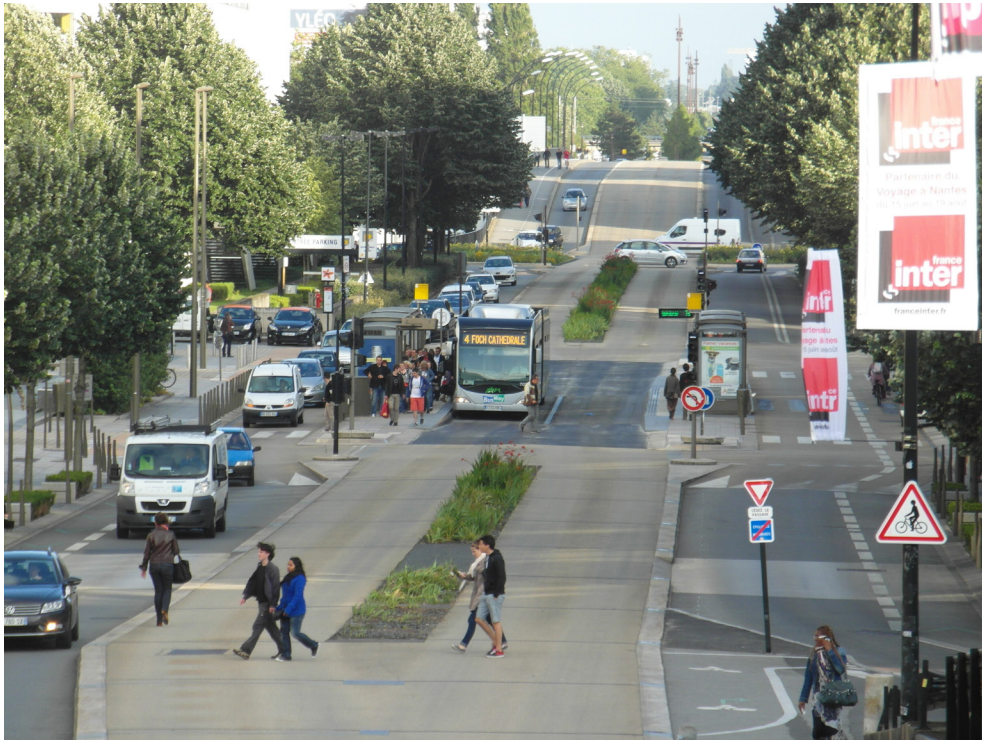
Abb. 52: BHNS-System in Nantes mit separierter ebenerdiger Trasse, Quelle: IngolfBLN 2012.
