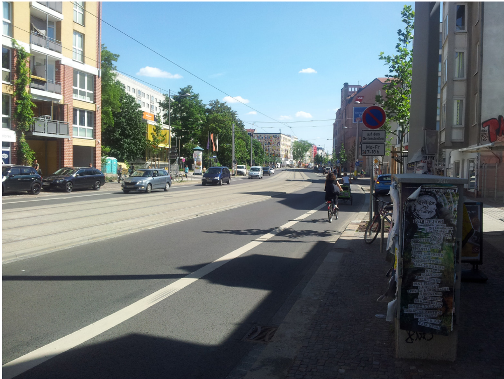
Abb. 56: Führung der Straßenbahn auf besonderen Bahnkörper mit geschlossenem Oberbau und Einfachfahrleitung in Leipzig, Quelle: Eigene Abbildung.
