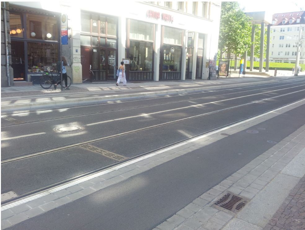
Abb. 66: Kaphaltestelle mit angehobener Radverkehrsanlage im Mischverkehr für die Straßenbahn in Leipzig, Quelle: Eigene Abbildung.
