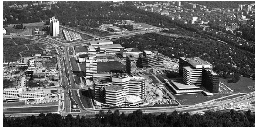
Abb. 42 Luftaufnahme City Nord
