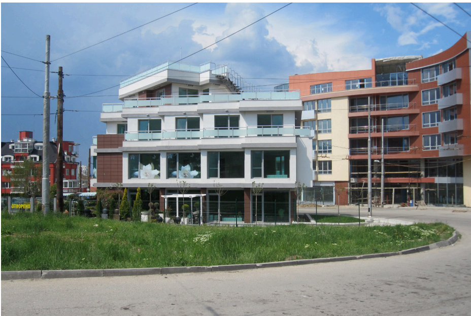
Abb. 3.6 (oben) und Abb. 3.7 (unten) : Geschosswohnungsbau (Neubau) am südlichen Stadtrand (Fotos Verena Gernert 2012)
