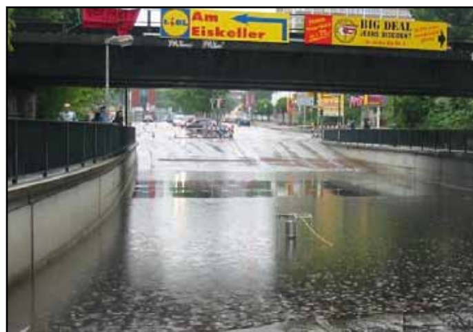
Abbildung 39: Vollgelaufener Bahntunnel „Badewanne“ (eigene Aufnahme)
