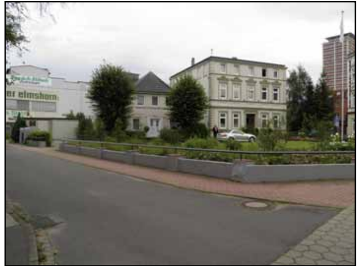
Abbildung 13: Gebäudebestand im Quartier Vormstegen (eigene Aufnahme)
