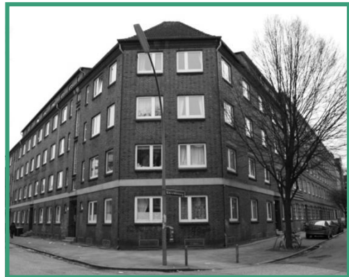
Abbildung 15: Wohnungsbestand Reiherstieg eG Bauvereinsweg (Quelle: Eigene Aufnahme 2012)
