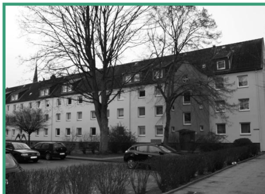
Abbildung 17: Wohnungsbestand Süderelbe eG Mannesallee (Quelle: Eigene Aufnahme 2012)
