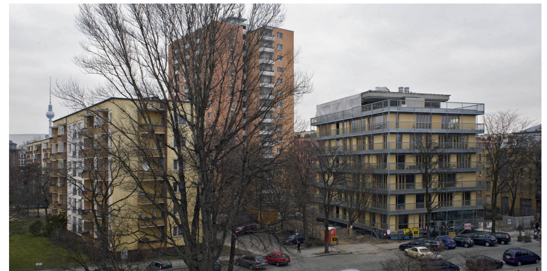
R50 nach Fertigstellung
