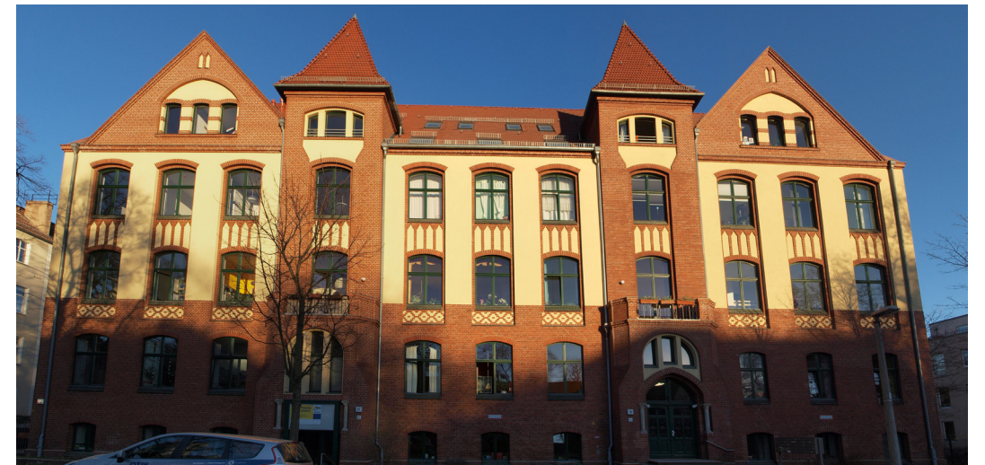
Straßenansicht der Alten Schule Karlshorst
