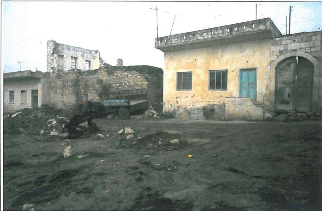
Abb. 76 Sqailbiya: Haus °Abdallāh aš-Šaiḥ (Kat. 10/7), Fassade
