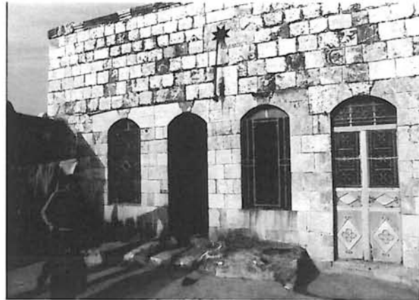
Taf. 9/3.2 Qal'at al-Maḍīq, Wohnhaus des Ḥālid °Abd l-Karīm, , Fassade im OG
