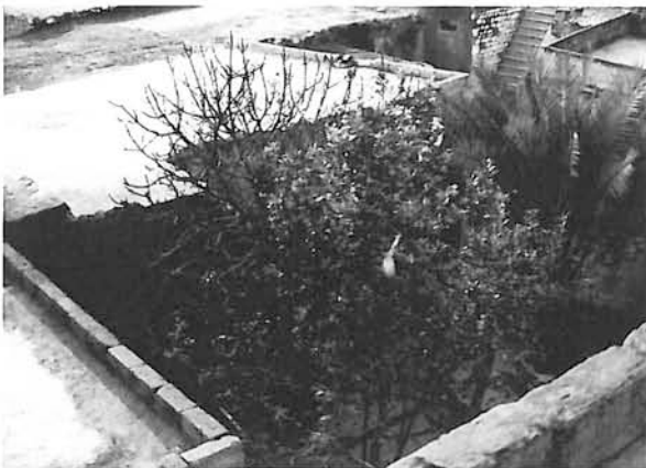
Taf. 9/3.3 Qal'at al-Maḍīq, Wohnhaus des Ḥālid °Abd l-Karīm, der Innenhof gesehen vom Dach des EG
