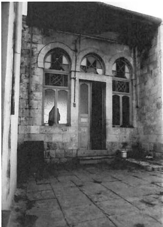
Taf. 9/4.1 Qal'at al-Maḍīq, Wohnhaus al-Ḥāğğ Firdaus ar-Rašīd, Innenfassade des Raumes 4
