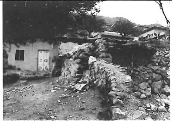
↑ Abb. 88 °Ain I-Krüm, Wand aus gefloch-tenen Äste;
