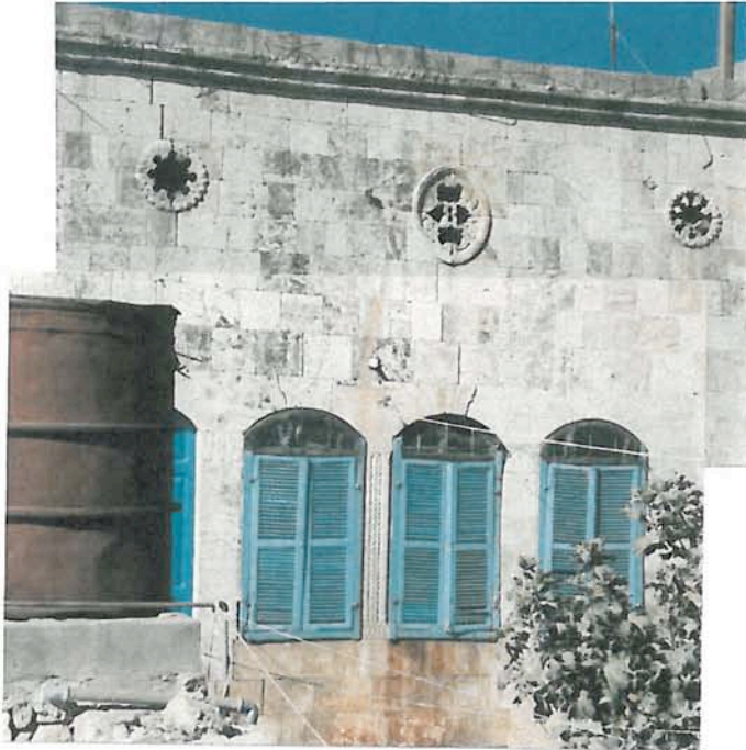
Taf. 10/7 Sqailbiya, Wohnhaus des Šaiḥ °Abdallāh S°ayyid al-°Abdallāh, Innenfassade des Haupttraktes (1)
