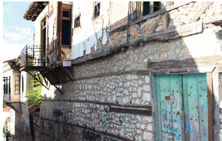
Abb. 039. Wohnbebauung in Veria, dem Straßenverlauf folgend, im Erdgeschoss bewehrtes Natursteinmauerwerk ohne Fensteröffnungen (eigene Aufnahme, 2013)
