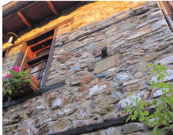
Abb. 047. Haus 2, massives Natursteinmauerwerk, durch Holzbalken bewehrt, Fenster ohne außenliegende Verschattungselemente (eigene Aufnahme, 2013)
