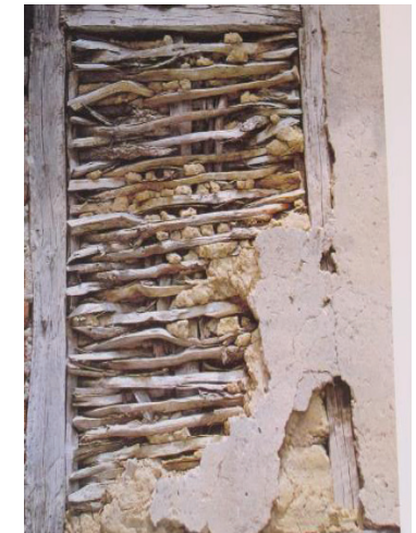
Abb. 041. Als satmas ausgebildete Außenwand (aus: Arneia 1990)
