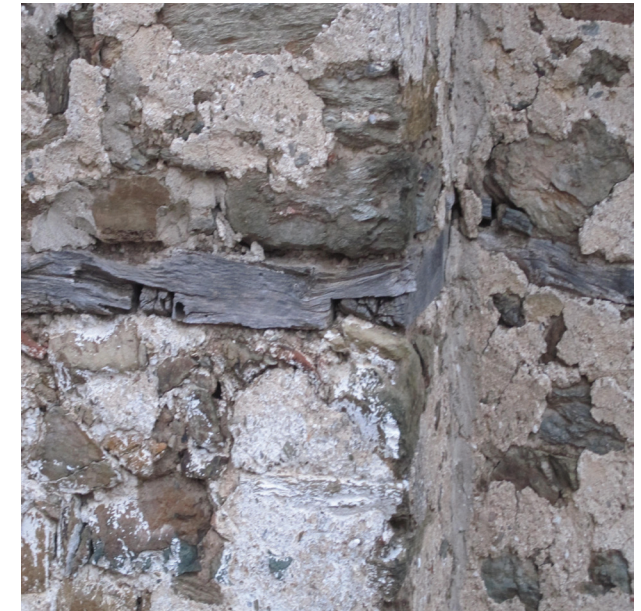
Abb. 017. Durch umlaufende Bewehrung gegen Erdbebenschäden gesichertes Mauerwerk eines Wohnhauses in Vrastama, einem Dorf östlich von Thessaloniki (siehe Kapitel 2.7 Vergleichende Betrachtung, eigene Aufnahmen, 2013)
