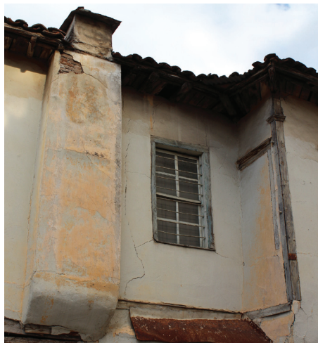
Abb. 038. Kaminzug an der Fassade eines Wohnhauses in Veria, Fenster mit zwei vertikal verschiebbaren Flügeln (eigene Aufnahme, 2013)
