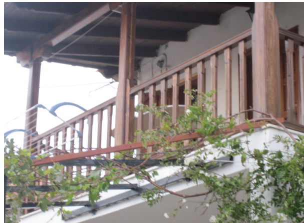
Abb. 046. Haus 1, nach Süden orientierter Balkon als Erschließung des Obergeschosses, laubabwerfende Rankpflanzen zur Verschattung des Vorplatzes (eigene Aufnahme, 2013)
