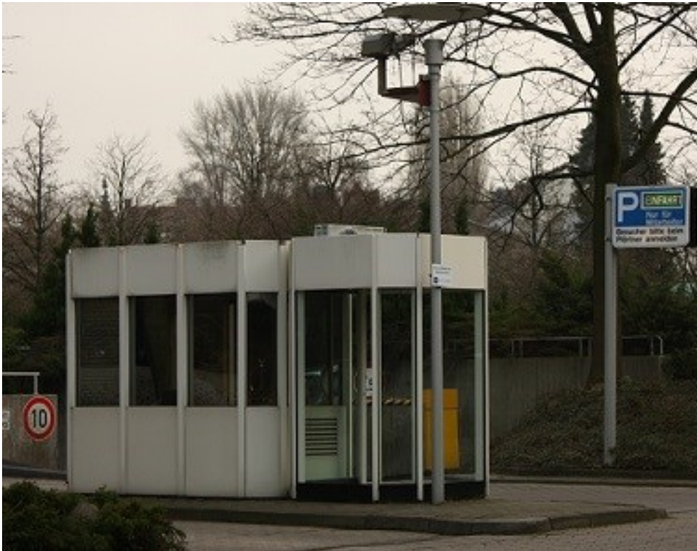
Bild 6-19: Hamburgs kleinstes Bürogebäude
