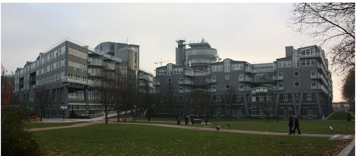
Bild 6-20: Hamburgs größtes Bürogebäude
