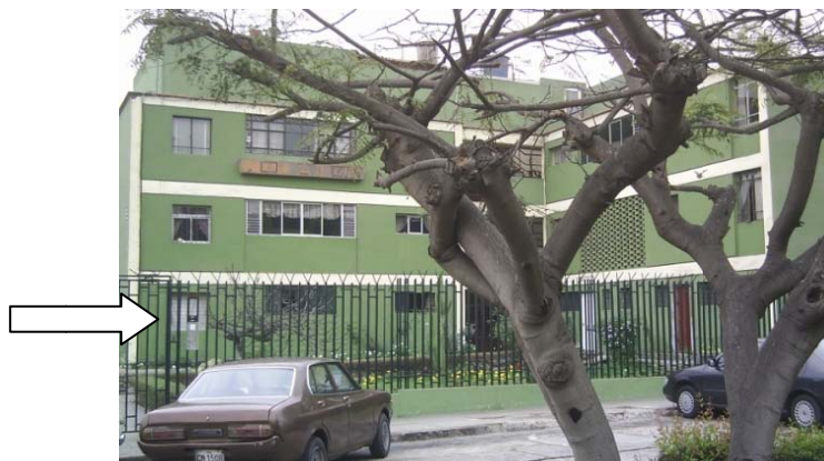
Neue Haustüren wurden in einigen Wohnung im EG eingebaut.
