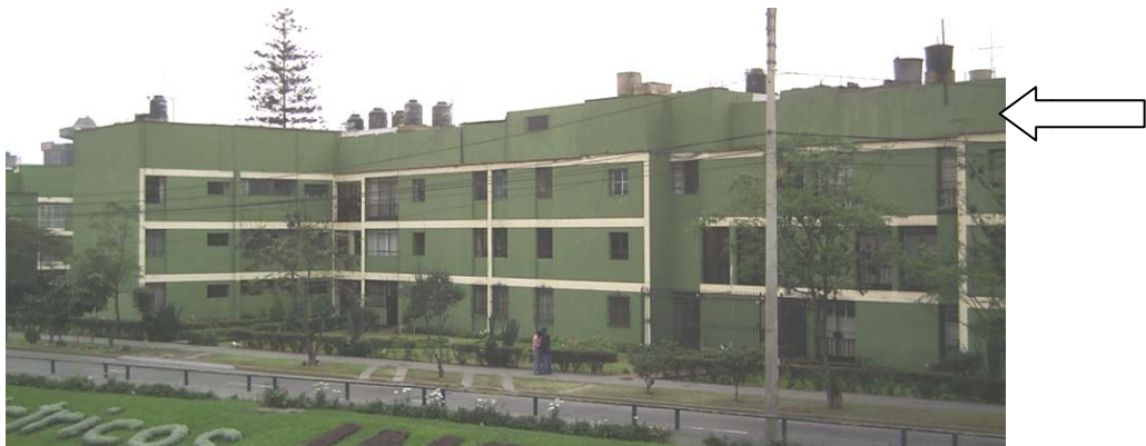
Die Wohnungen im letzten Obergeschoss wurden auf dem Dach des Wohnblocks erweitert
