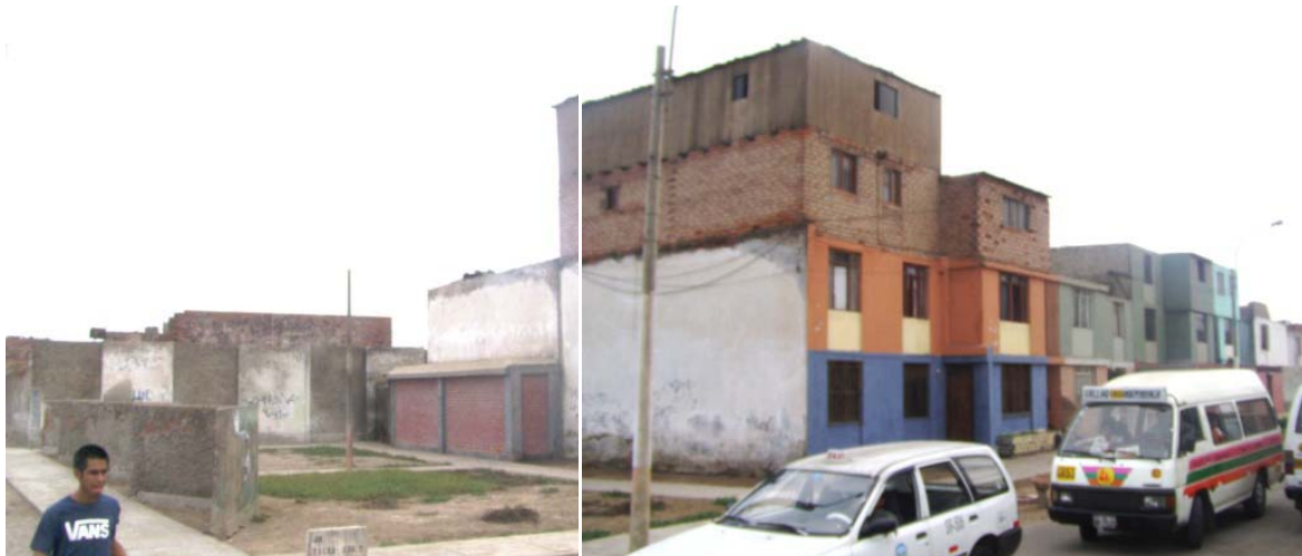
Erweiterungen durch Dachaufbauten und Anbauten
