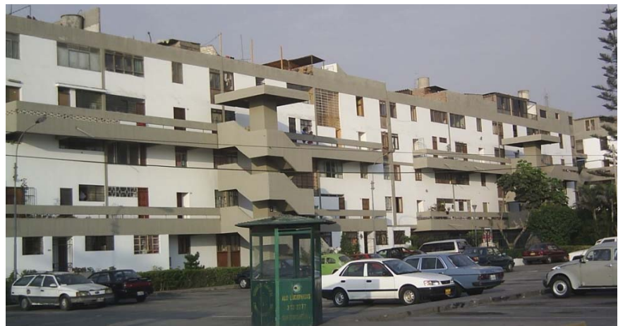
Einige Dachaufbauten und Erweiterungen unter dem Laubengang Foto: M. Caldas 2007
