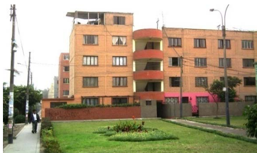
Wohn-Kern durch Dachaufbauten Fotos: MP.C.T. 2008
