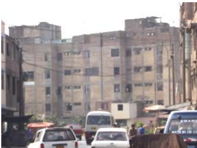
Wohnblock des CHManzanilla in der Straße Alto de la Alianza mit Anbauten und Dachaufbauten
