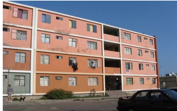
Außenraum des „U-förmigen“ Wohnblocks
