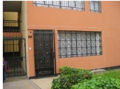
Neue Haustür im EG Foto: P.C.T. 2008
