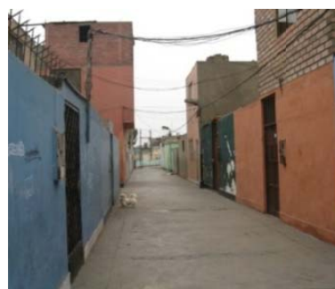
Erweiterungen am Laubengang
