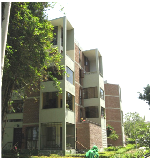
Ansicht einiger Erweiterungen auf den doppelt so hohen Balkonen. Fotos: P.C.T. 2010
