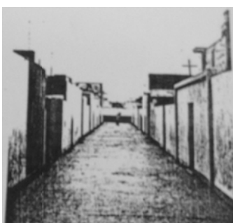
Laubengang im OG
