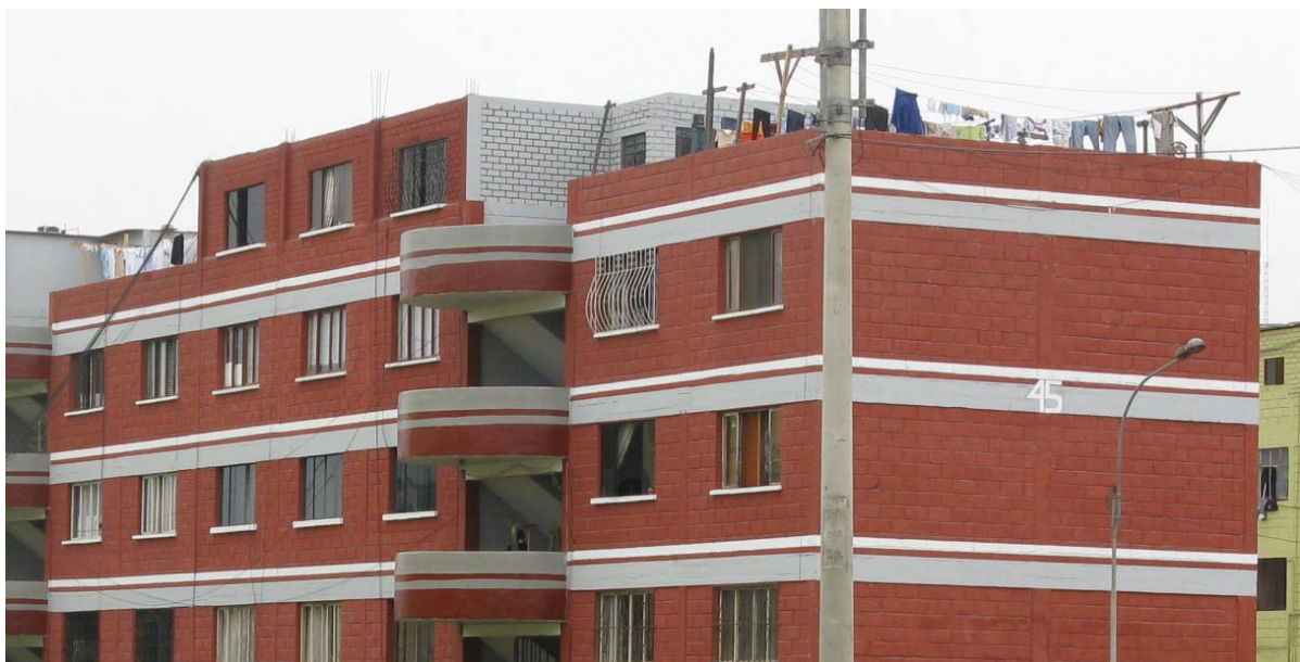
Dachaufbauten auf gemeinsamer Terrasse, Zeile, UV3
