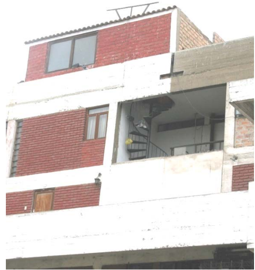
Eisentreppe auf dem Laubengang, vierte Etage, Zeile im CHManzanilla und Zeile in UVMirones
