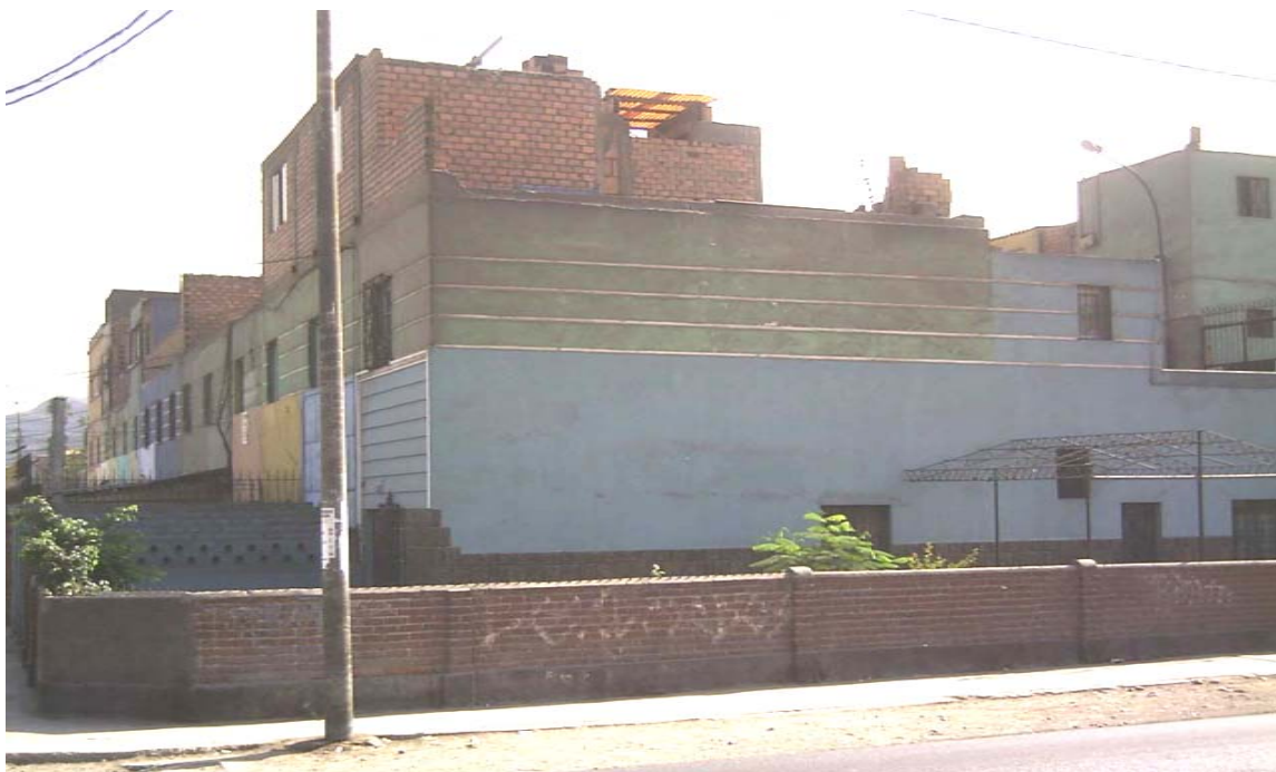
Neue Fenster- und Türöffnungen auf vorhandener Blockquerfassade einer Blockbebauung (B. Obrero N°3)
