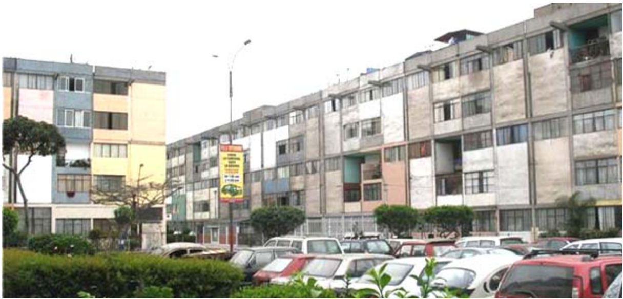
2010. Fassade mit Veränderungen, die doppelt so hohen Terrassen wurden aufgefüllt
