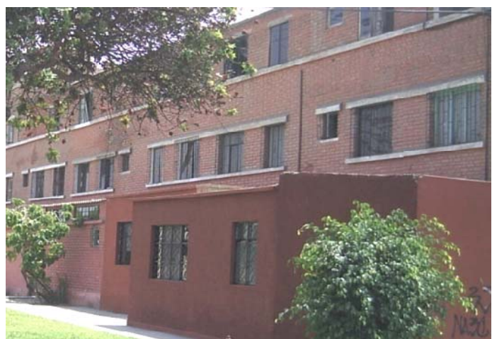
Ausbauten in einem H2W-UV3. Foto: PCT 2008
