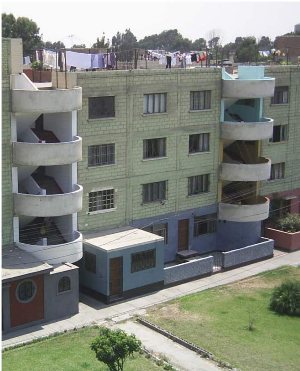
[57] Typ B: Schaffung neuer Eingangszone auf der Vorderfront der Wohnung im Erdgeschoss durch Ausbauten (Zeile, UV3)
