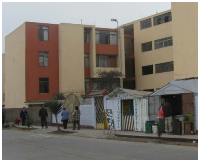
[49] Gebauten Läden auf der Grünfläche der Siedlung (CHPalomino). Foto: P. C. T., 2010
