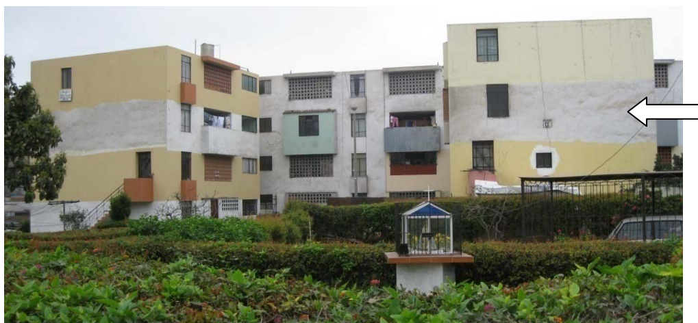
[76b] Tür- und Fensteröffnungen auf seitlichen Baufronten, CHPalomino. Fotos P.C.T. 2008
