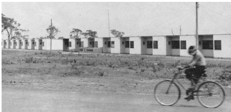
[13] Arbeiterwohnungen einer Trabantenstadt Brasílias. Quelle: Stäubli (1966), S.55
