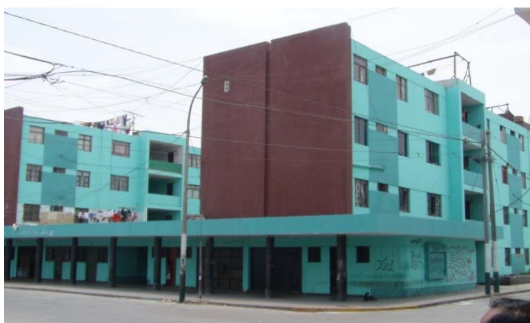
Eine Ecke der Wohngruppe [36] Agrupamiento Olaya, Ansichten
