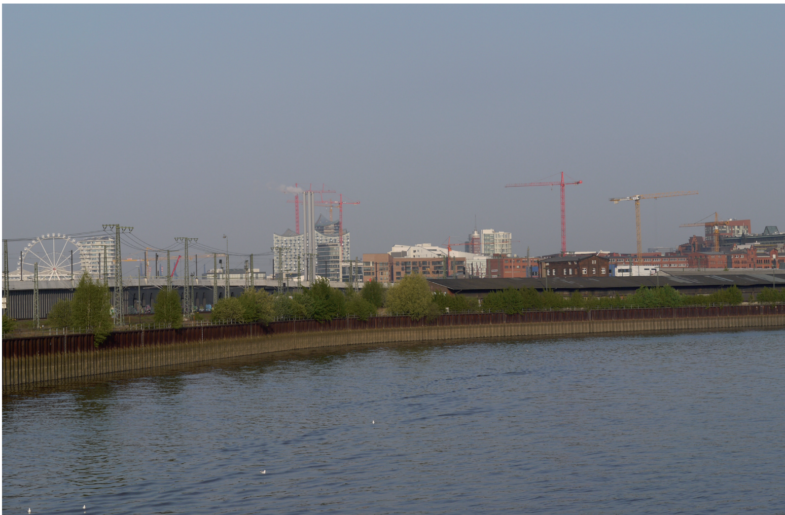
Abb. 42 (o.l.): Barrierewirkung durch Flutschutz und Eisenbahnbrücken; Abb. 43 (o.r.): Nördlicher Bahndamm als Barriere, der den Großmarkt nach Hammerbrook hin abschottet; Abb. 44 (u.): Pfeilerbahn als weitere Barriere zur geplanten HafenCity (alle eigene Fotos)
