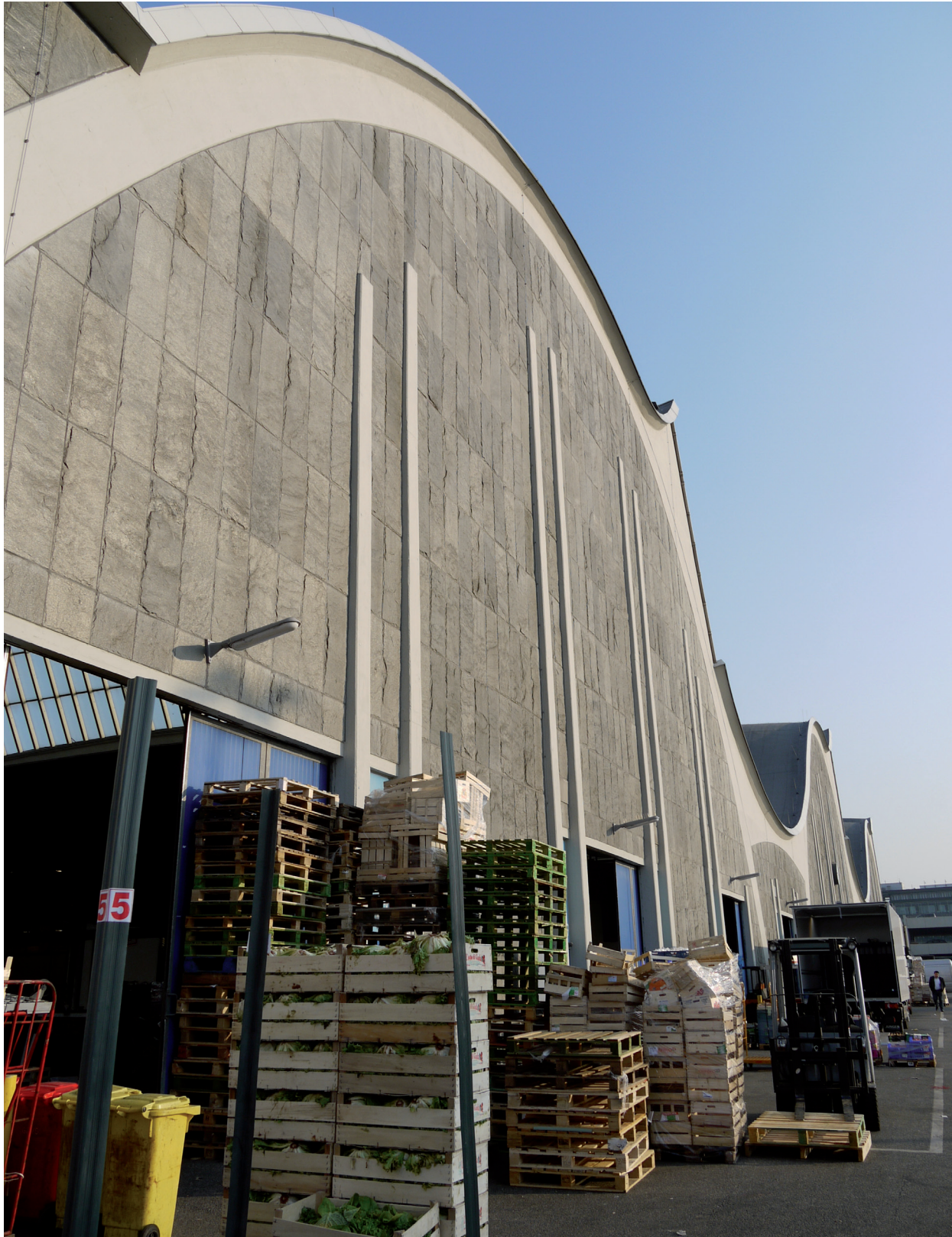
Abb. 1: Ostfassade der Großmarkthalle (Eigenes Foto)
