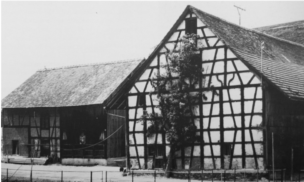
Abb 2.10 - Fachwerkhäuser als Typologien der gemäßigten Klimazonen. Das Bild oben stammt aus Süddeutschland und das Schema aus einem britischen Haus in Devon.
