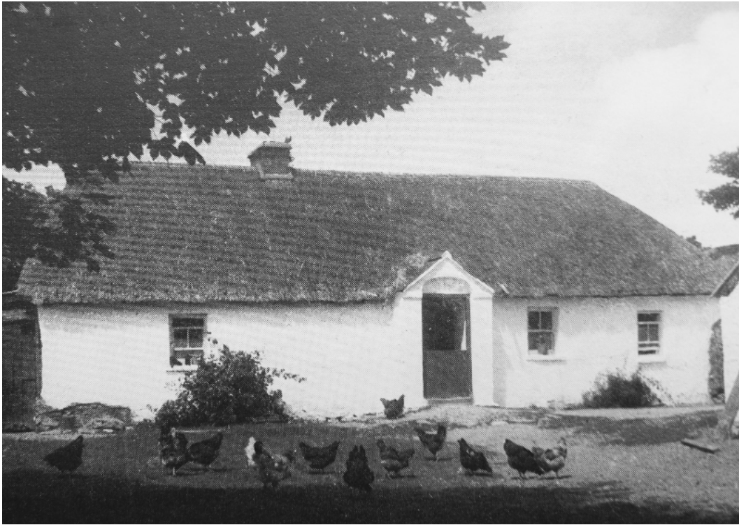
Abb 2.9 - ein irisches Bauernhaus. Kompakte Bauweise mit schweren Materialien und stark gedämmtem Dach.
