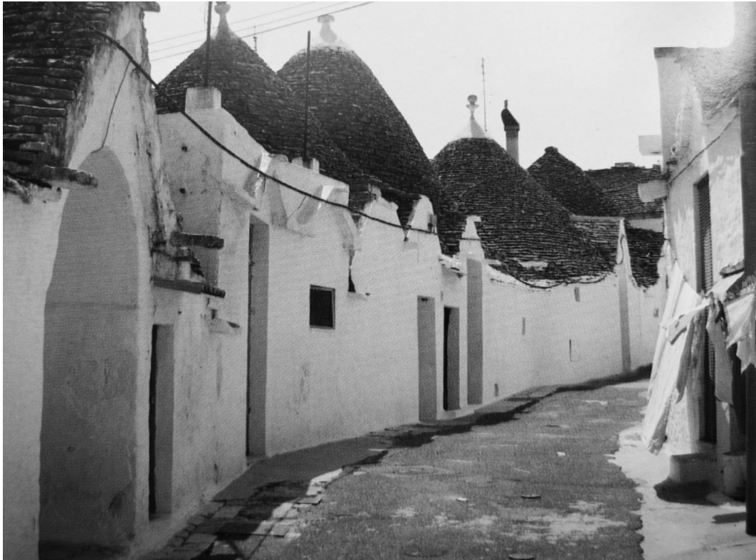
Abb 2.8 - die Trulli sind eine Bauweise in Süditalien, einem Übergangsgebiet der gemäßigten Klimazone und der trockenheißen Zone. Die Baukörper sind sehr kompakt und die weißgestrichenen Fassaden bieten Schutz gegen die Hitze, da sie das Sonnenlicht reflektieren.
