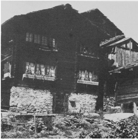
Abb 2.11 - ein Beispiel aus dem kalten Gebiet. Ein Haus in Törbel, Schweiz. Die Gründung ist aus Stein gemauert, aber die Wände sind aus Holz (starke Dämmfähigkeit).
