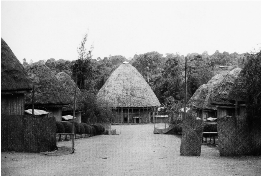
Abb. 2.5 - Typologien aus einer Siedlung im feuchten, warmen Klima Kameruns. Starke gedämmt und geneigte Dächer leisten Schutz gegen Sonneneinstrahlung und starken Regen. Das Detailfoto zeigt eine winddurchlässige Bauweise.
