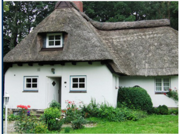
Abb. 77 - Appartementshaus des Seeschloss Hotels
