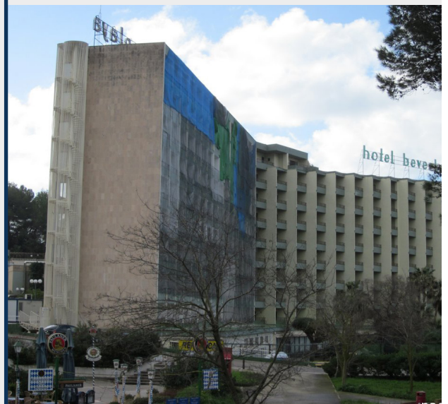
Abb. 5 - sanierungsbedürftiger Hotelkomplex (Quelle: pagueraurlaub)
