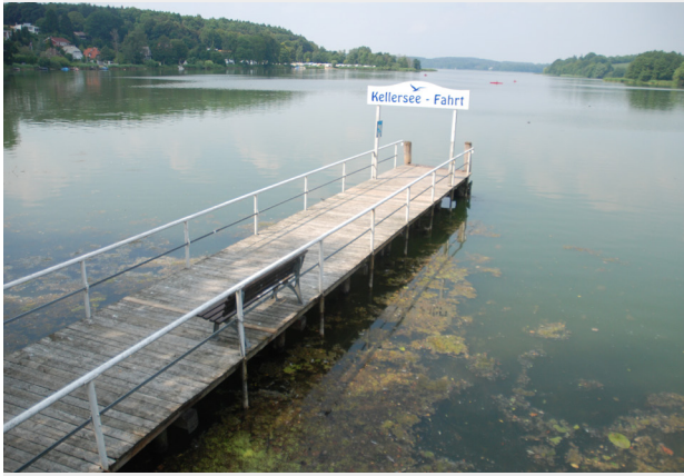
Abb. 94 - Fähranlegersteg in Fissau mit Blick über den Kellersee
