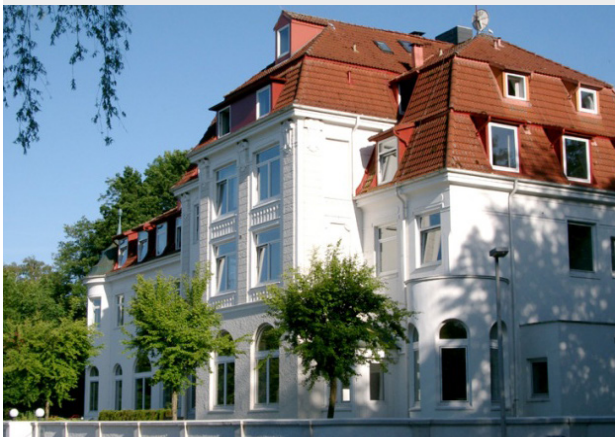
Abb. 76 - Seeschloss Hotel (Leonhard-Boldt-Straße - tour. Bereich)
