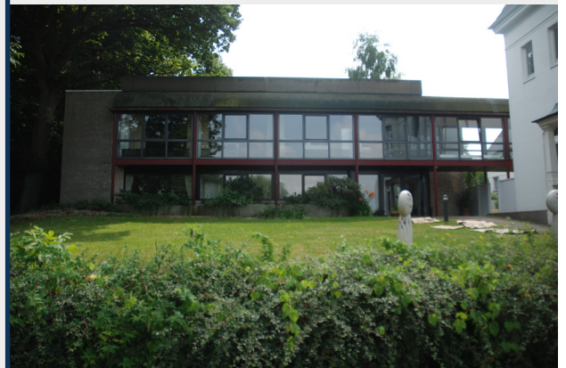
Abb. 110- Seeschloss Hotel- unpassend wirkender Anbau
