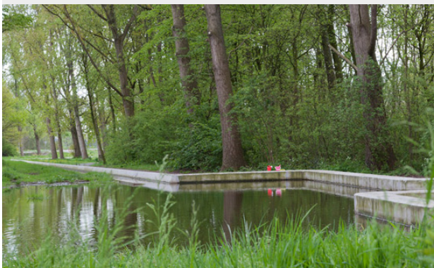
Abb. 208 - Beispiel befestigte Uferkante
