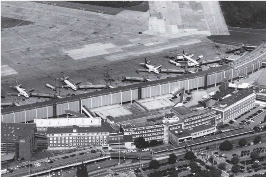
Abb. 29: Umbau des Flugplatzgebäudes in Fuhlsbüttel zum modernen Terminkomplex in den 1990er Jahren
