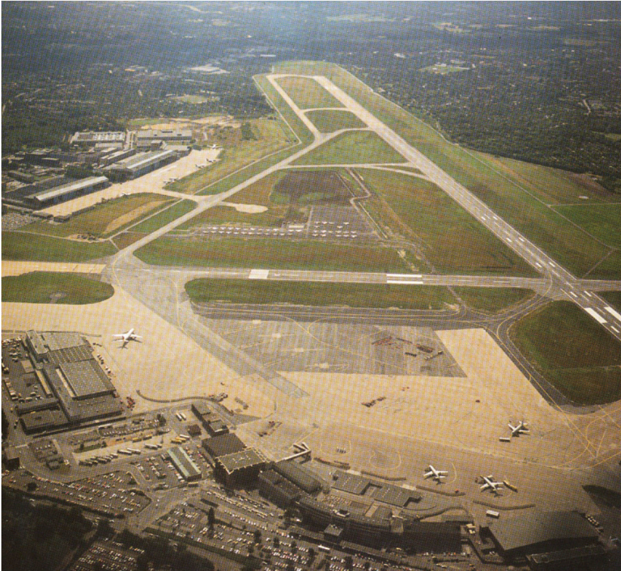
Abb. 13: Der Flugplatz Fuhlsbüttel wird mit modernen Düsenjet-tauglichen Start- und Landebahnen ausgestattet
