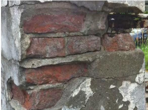
Abb 37 Zementmörtel
