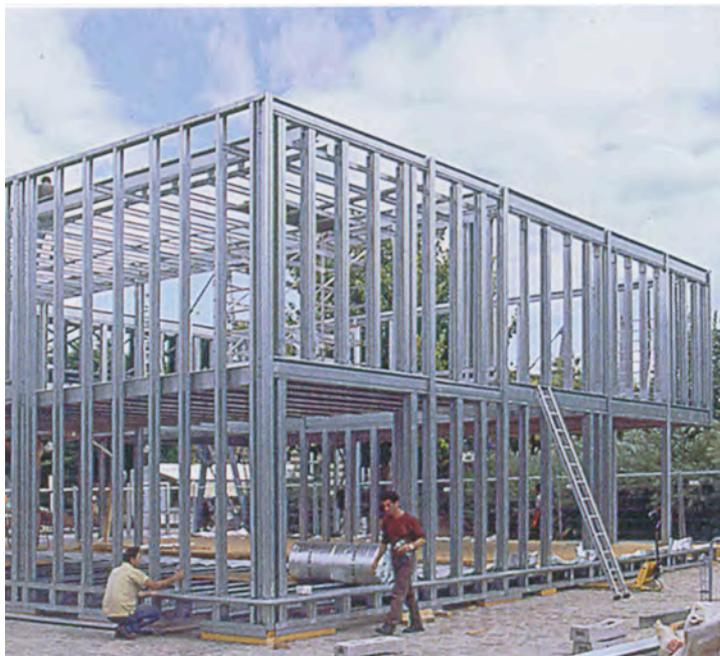
Abb 121 Stahlleichtbauskelett aus Atlas moderner Stahlbau, S. 97
