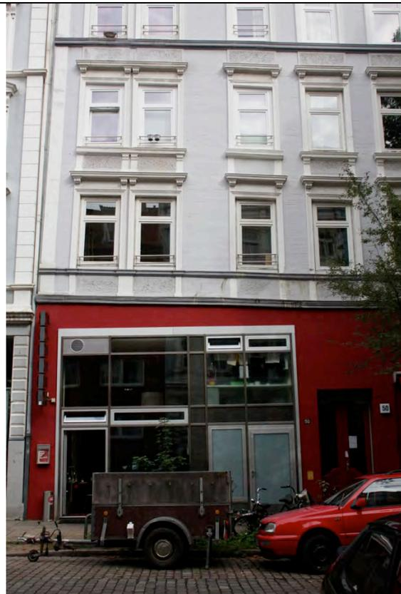
Abb 57 Ausschnitt Setzungen Lindenallee 50, gerade eingebaute Pfosten-Riegelfassade und abfallende Gesimse
