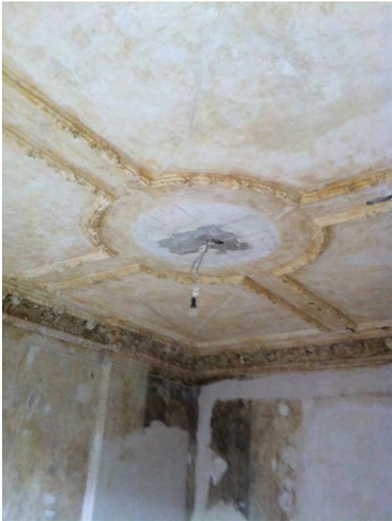
Abb 106 Gipsputz auf Schilfrohmatten und Gipsstuck
