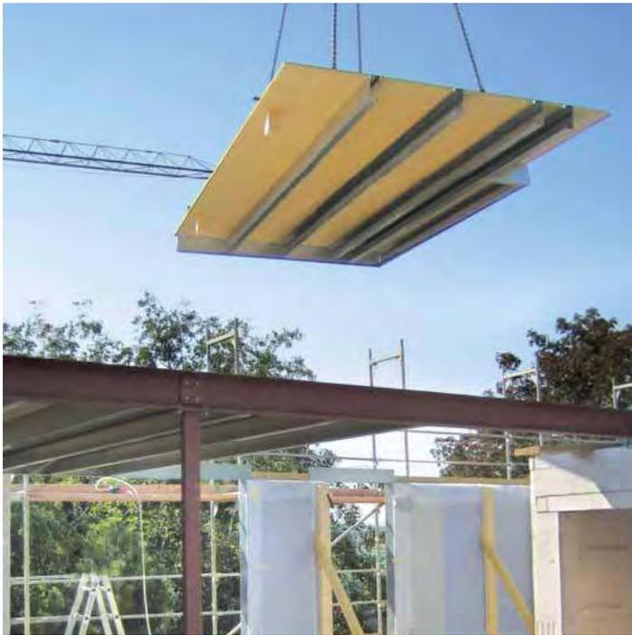
Abb 91 Stahl-Leichtbau Deckenelement aus C-Profilen aus (220) S. 13
