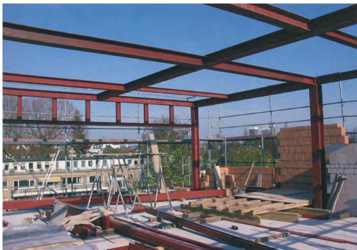
Abb 120 Stahlskelett der Gebäudeaufstockung in der Herbert Weichmannstr. Hamburg, Schöning Spalt Architekten in Schönberger/Dachaufbauten
