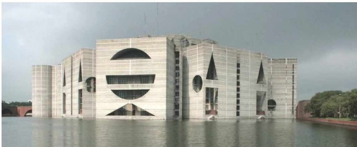
Abb.3.1.11: Parlamentsgebäude für Bangladesh ( http://openbuildings.com/buildings/bangladesh-national-assembly-building-profile-2655 )
