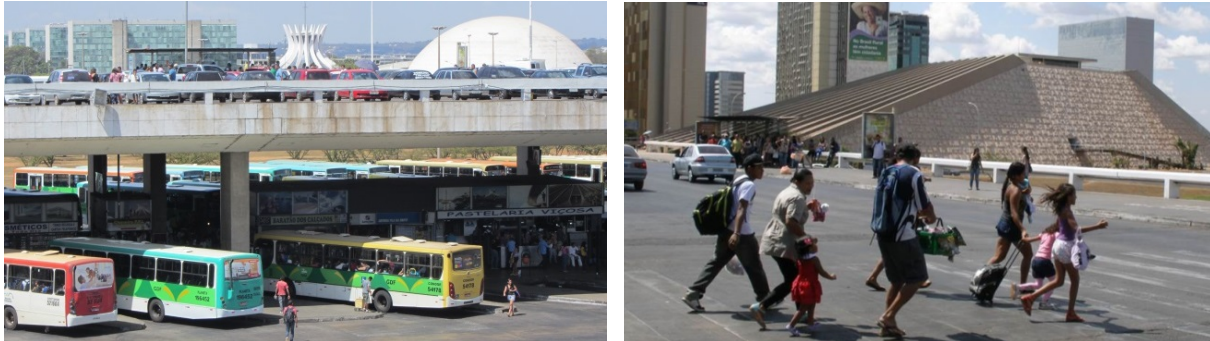
Abb. 70+71: Bus- und Parkdeck; Fahrgäste auf einem von Autofahrern nicht beachteten Zebrastreifen auf dem Weg zur Haltestelle am Busbahnhof (Bartscher/Bose 2013)
