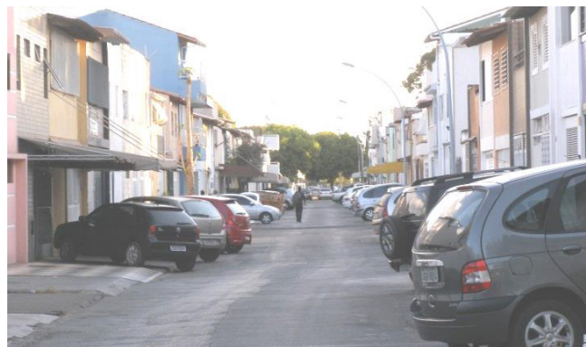
Abb. 17: Erschließungsstraße für die zwei- bis dreigeschossigen Reihenhäuser im Süd-Arm des Plano Piloto (Bartscher/Bose 2013)
