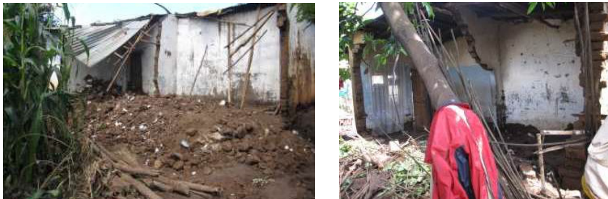
Abb.34+35: Hochwasserschäden am Mchesi River, Area 8 (Kulemeka 2012:19a+b)
