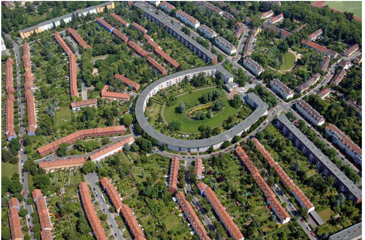
Abb. 48. Großsiedlung Britz (Hufeisensiedlung), Berlin Partner GmbH o.J.
