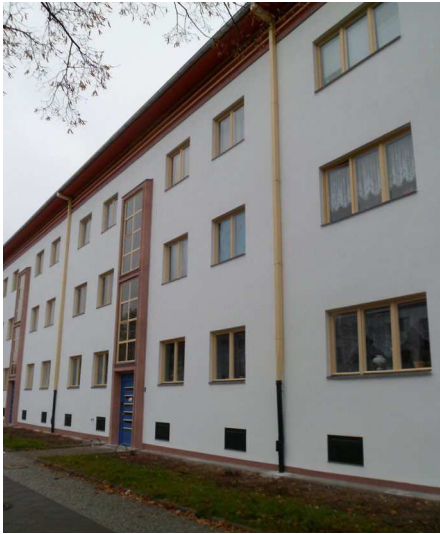
Abb. 58. Farben auf den Fassaden, Eigenes Foto
