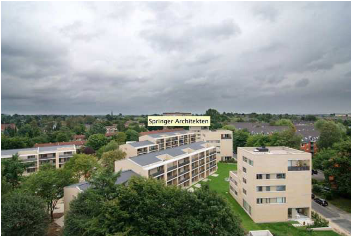
Abb. 68. Siedlung nach dem Umbau, Hiepe o.J.
