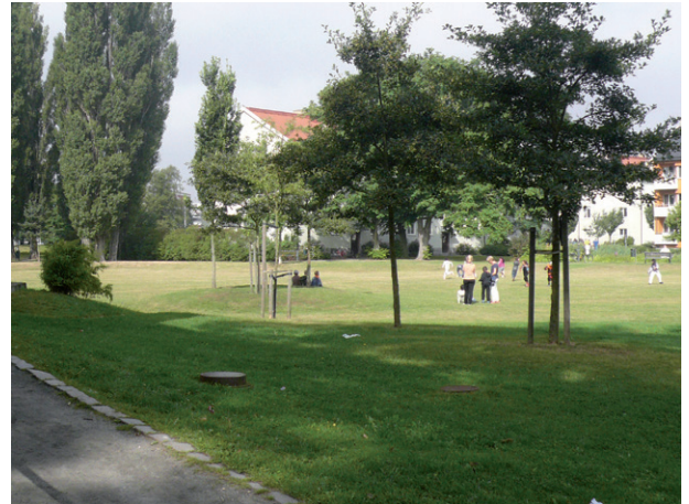
Abb. 1.3: Eine bestehende Grünfläche wurde in Malmö im Stadtteil Augustenbourg nachträglich „tiefergelegt“ zur Überflutungsvorsorge des angrenzenden Wohngebietes.
