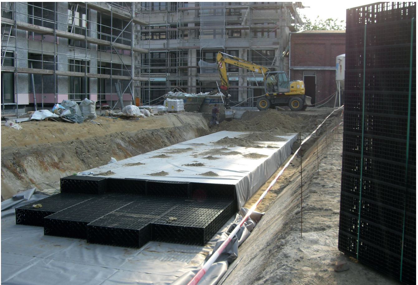
Abb. 4.2.2.5: Einbau einer Kunststoffrigole, die auch befahren werden kann.
