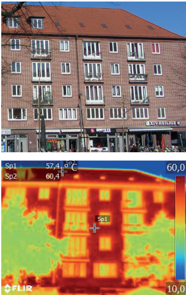
Abb. 2.4.1: Das Thermalbild zeigt den Bedarf nach Maßnahmen zur Hitzevorsorge am Gebäude.
