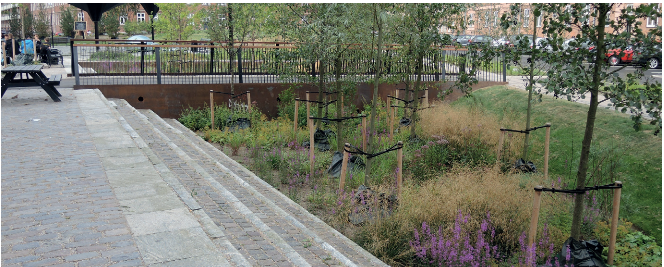
Abb. 2.2.1: Der tiefgelegte u. begrünte St. Kjelds Platz in Kopenhagen hält nun bei Starkregen das Wasser temporär zurück.
