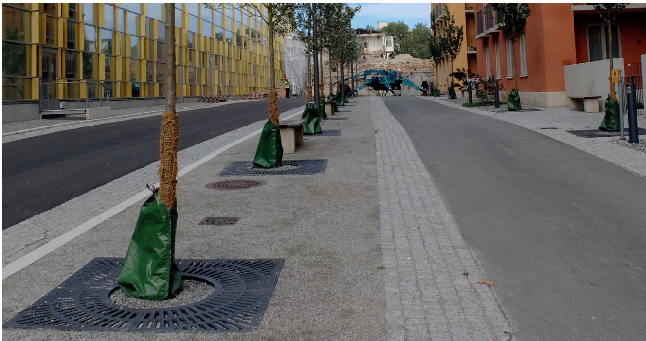
Abb. 4.2.2.8: Beispiel für die Versickerung von Regenabflüssen in den Pflanzgruben von Straßenbäumen im öffentlichen Raum (Stockholm).
