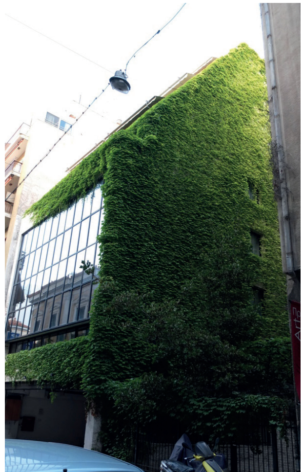
Abb. 2.4.2: Fassadenbegrünung als mögliche Maßnahme zur Hitzevorsorge.
