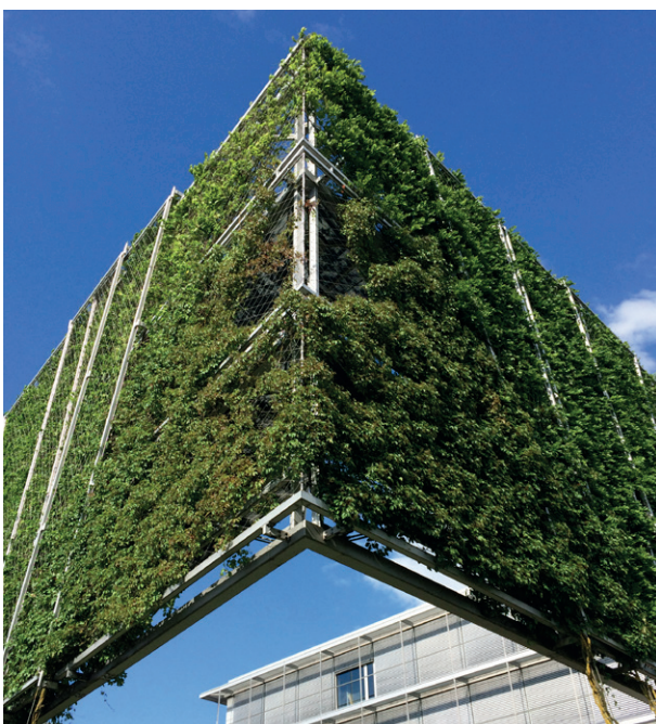
Abb. II.1: Bodengebundenes Begrünungssystem.
