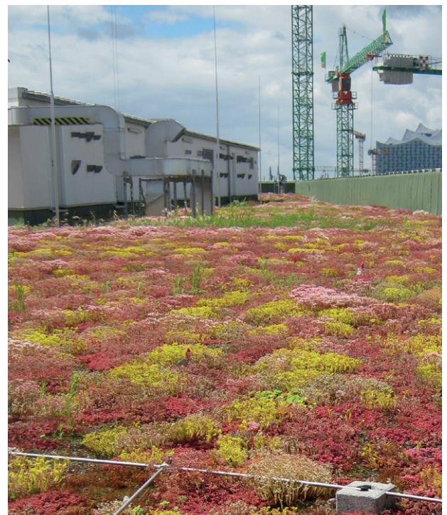
Abb. 4.3.2.5: Schon ein extensives Gründach wie auf dem Gebäude der HCU kann die Oberflächentemperaturen auf dem Dach deutlich reduzieren.
