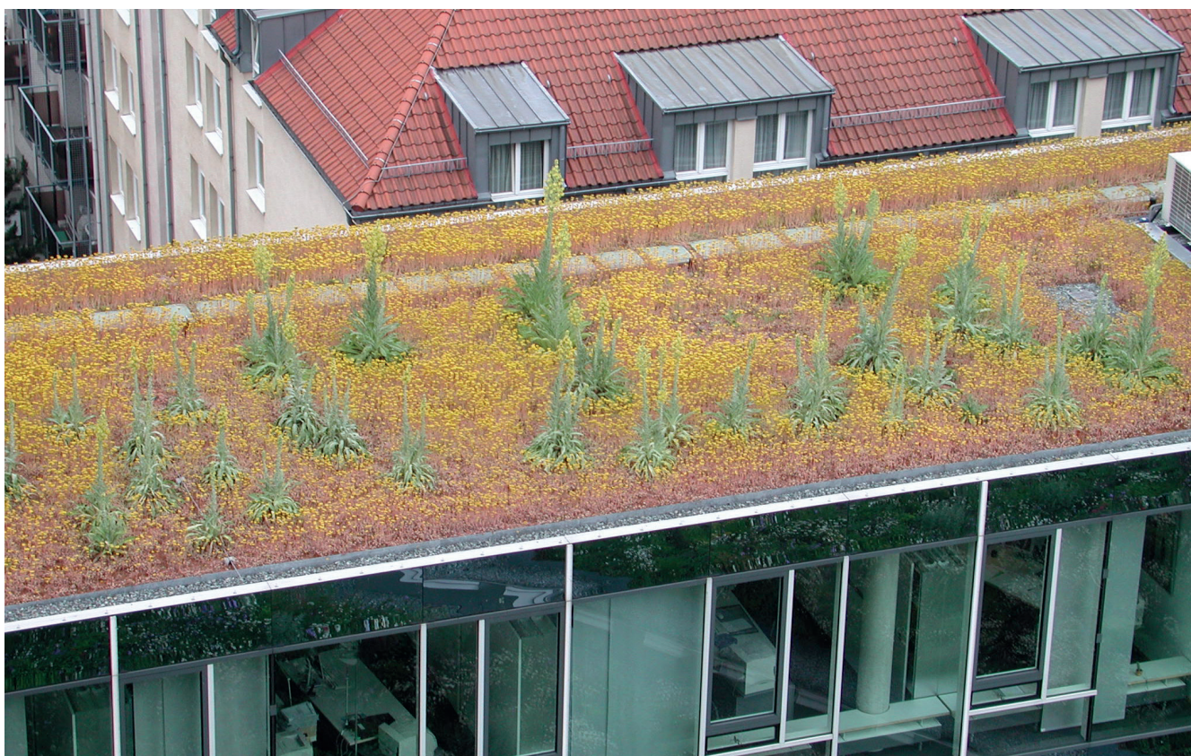
Abb. 3.1.2: Begrünte Dachflächen auf einem Bürogebäude in Hannover halten Niederschlag zurück.
