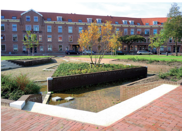
Abb. 4.2.4.2: Umbau einer Grünfläche zu einem wasserspeichernden Platz in Rotterdam.
