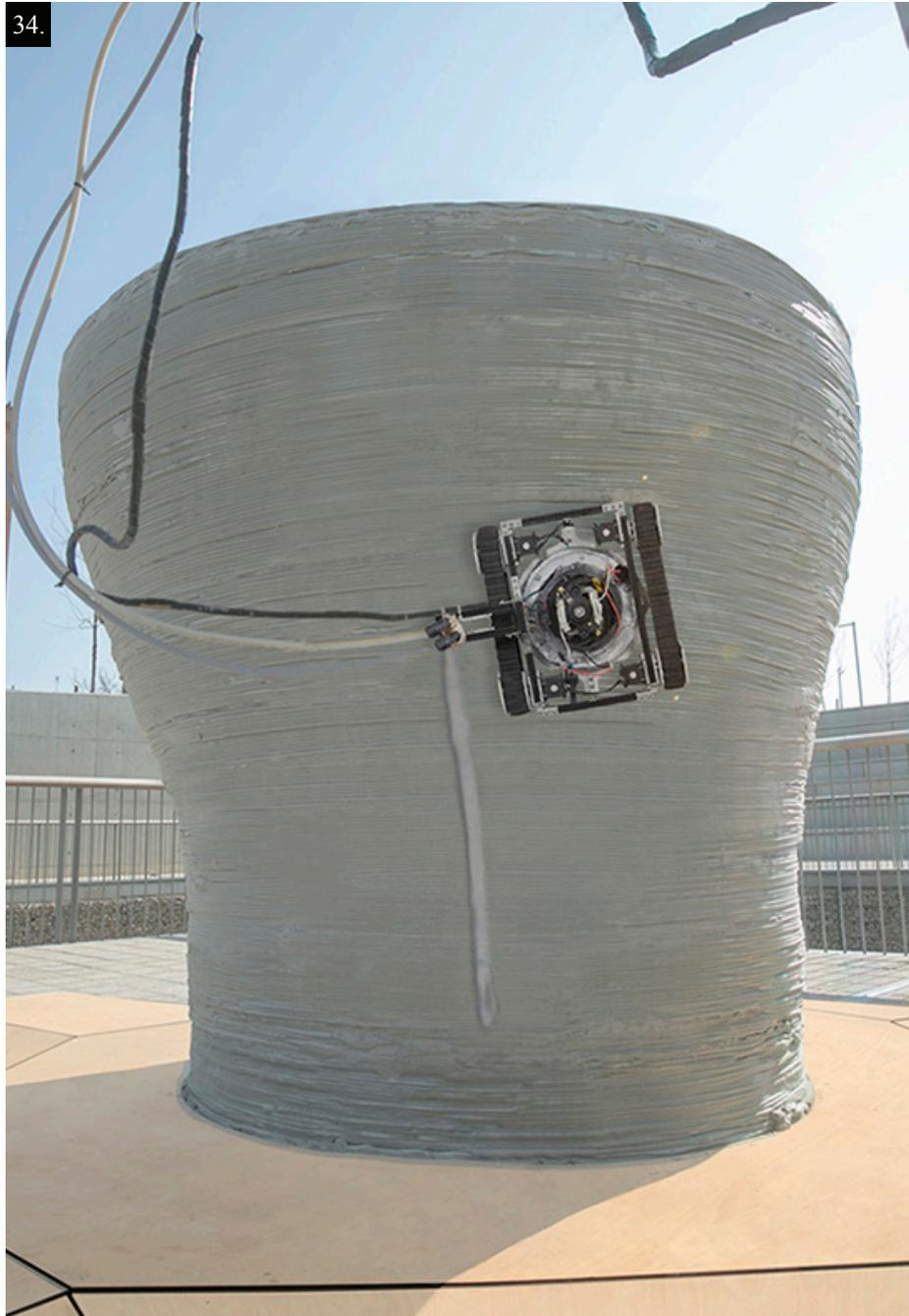
34. Ablagerung der vertikalen Aussteifungsschichten, Vacuum Robot, Minibuilders
