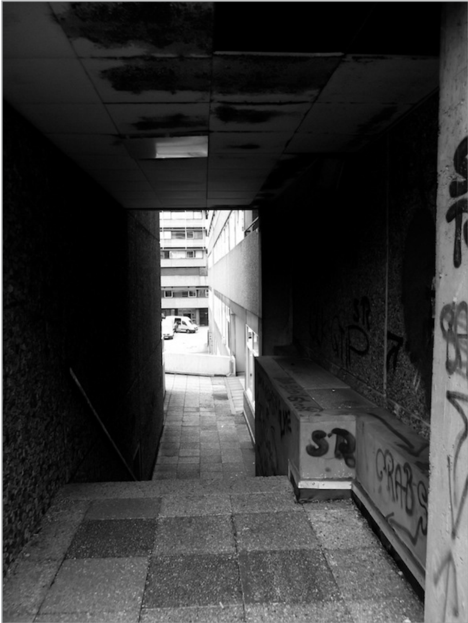
Abb. 08: Durchgang auf Höhe der Ladenpassage „Ebene +1“ (Quelle: eigenes Foto, 2013)
