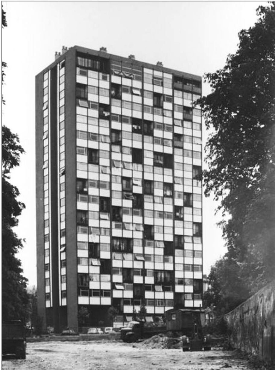
Abb. 41: „Tour Bois-le-Prêtre“ vor seiner Revitalisierung (Quelle: http://www.lacatonvassal.com , 2014)
