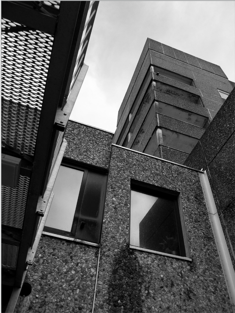
Abb. 03: Charakteristische Materialien und Formen des zentralen Gebäudekomplexes (Quelle: eigenes Foto, 2013)
