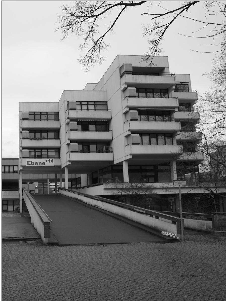
Abb. 07: Wohnungen im südlichen Teil des zentralen Gebäudekomplexes (Quelle: eigenes Foto, 2013)
