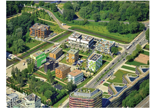
Abb.44: Nördlicher Teil des Plangebietes (IBA Hamburg)
