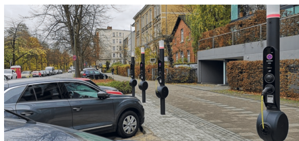
Abb. 98: Qwello Ladestationen im Lehmweg in Hamburg (Schaal 2020b)
