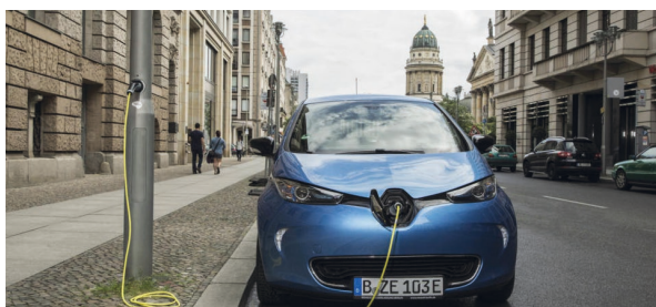
Abb. 97: Ubitricity: Nachrüsten von Ladepunkten in bestehende Lichtmasten in Berlin (Ubitricity o.J.)
