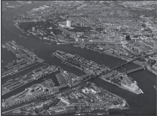
Abb. 6: Kop van Zuid vor dem Umbau, 1985
