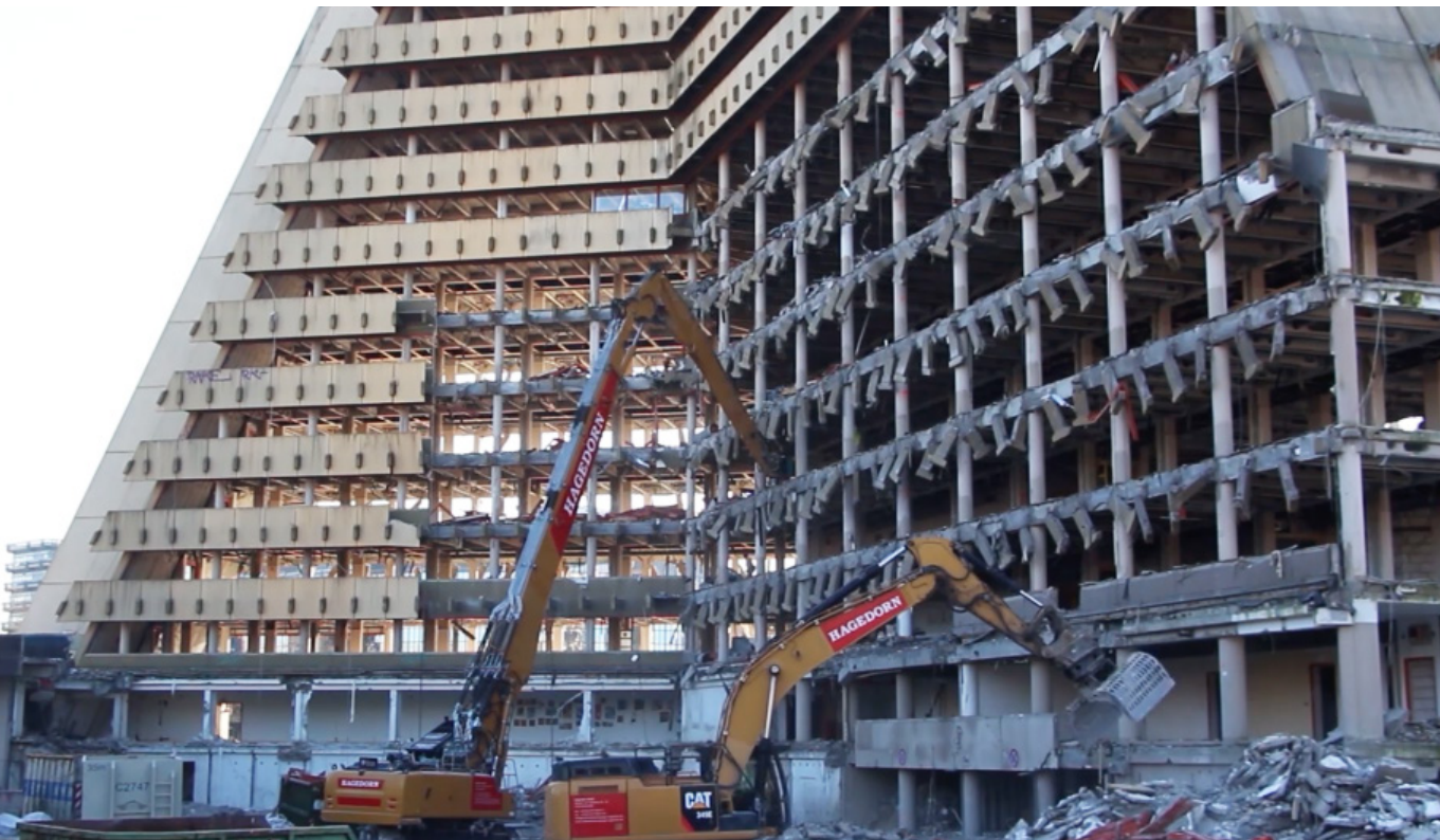
Am Ende siegen die Bagger. Abriss der ‚Post-Pyramide‘ in der City-Nord © Merle Dierks, Sophie Schätzle
