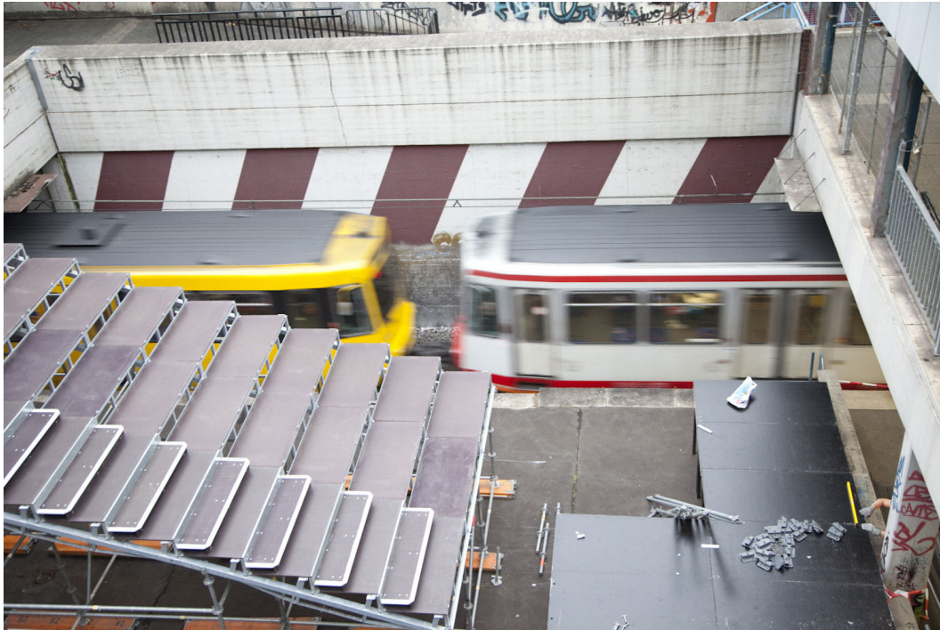
Bild 7: Aufbau der Tribüne und Bühne bei U-Bahnbetrieb, © Guntram Walter
