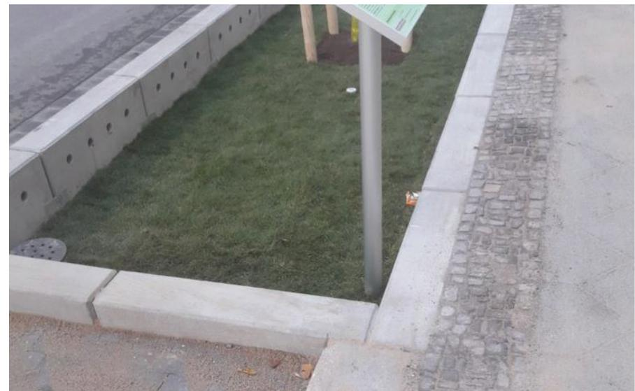
Abb. 46 - Tiefbeet mit Lochbohrung als Zulauf [3]
