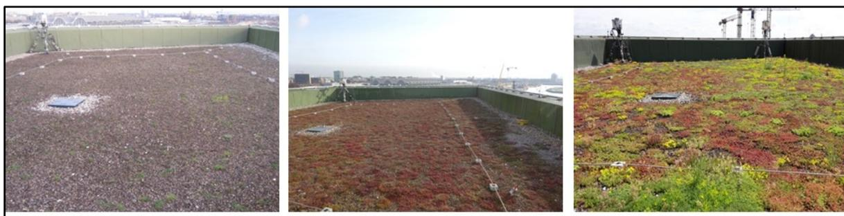
Abbildung 12: Entwicklung der Pflanzenbedeckung am Nordteil des Gründachs im Februar 2015 (Links, Bedeckungsgrad < 20%), März 2016 (mitte, Bedeckungsgrad ~ 70%) und Juni 2017 (Rechts, Bedeckungsgrad ~ 90%).
