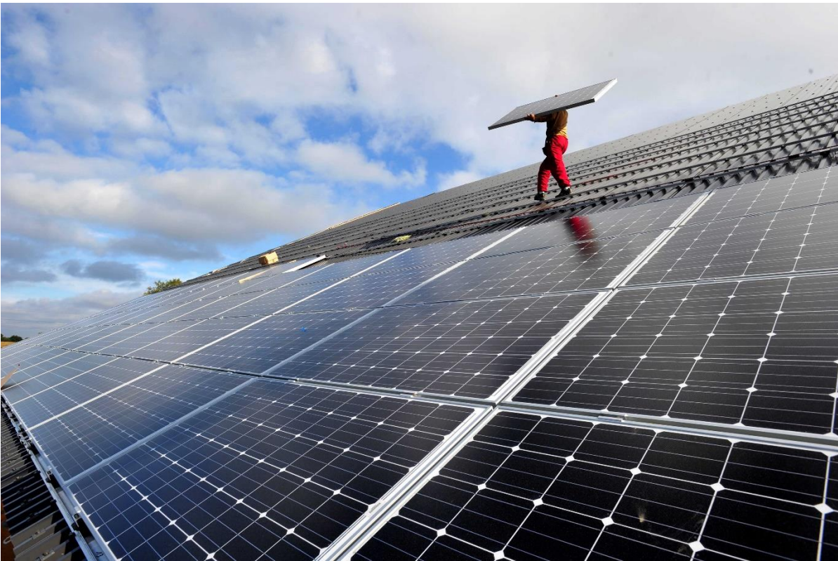
Abb. 8: Die Montage von Photovoltaik-Elementen (STRING Network 2012)
