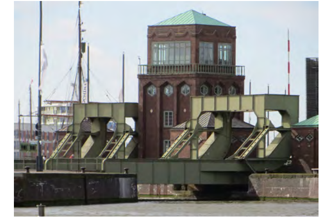
Abb. 34: Klappbrücke zwischen Altem und Neuem Hafen
