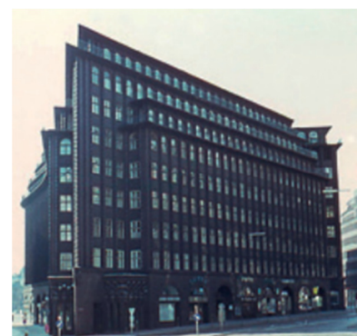
Abbildung 2.1.2: Chilehaus im Kontorhausviertel
