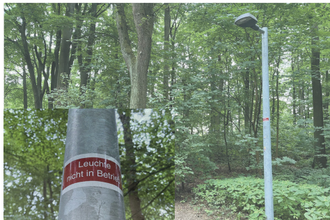
Abb. 67: Neue Beleuchtung für Läufer:innen im Volkspark
